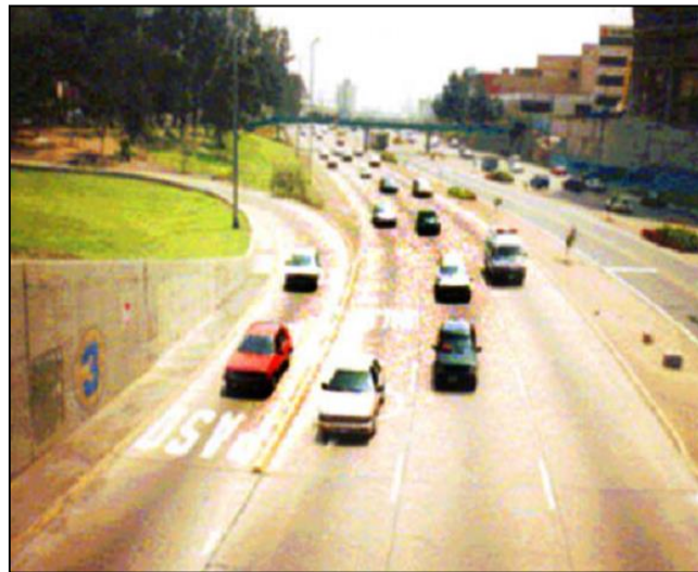
Figura 11: Nivel de servicio C
