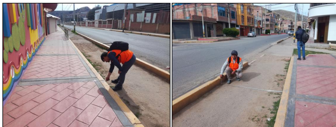
Figura 32: Levantamiento en campo (Características de la vía)
