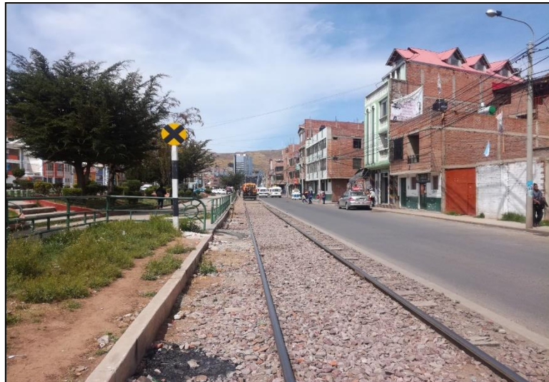
Figura 45: Señal cruce ferroviario
