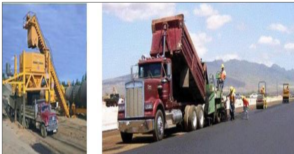
FIGURA 14: Sobre carpeta de Asfalto. FUENTE: Medina & De la Cruz, 2015
