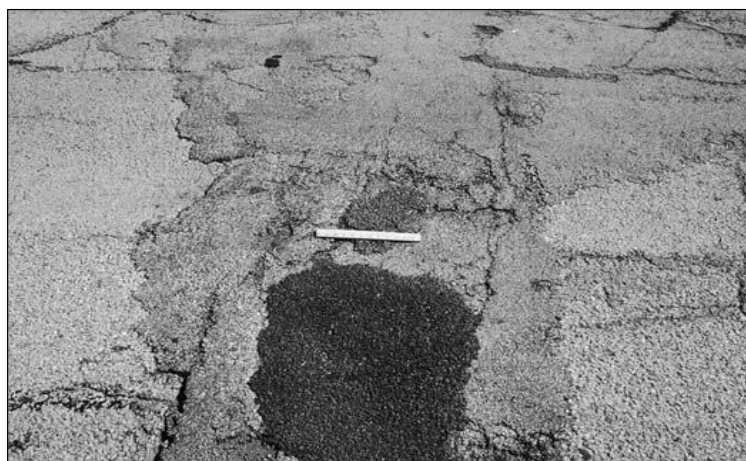
FIGURA 59: Severidad Alto (H) de Parches y Cortes Utilitarios. FUENTE: American society for testing and materials, 2018.
