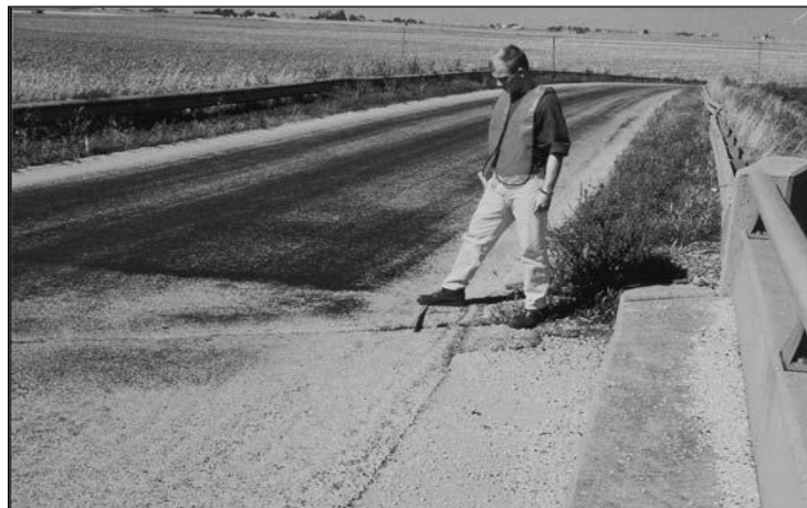
FIGURA 67: Severidad Baja(L) de Desplazamiento. FUENTE: American society for testing and materials, 2018.
