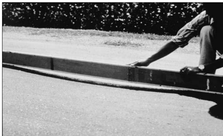
FIGURA 43: Severidad Medio (M) de Depresión.
