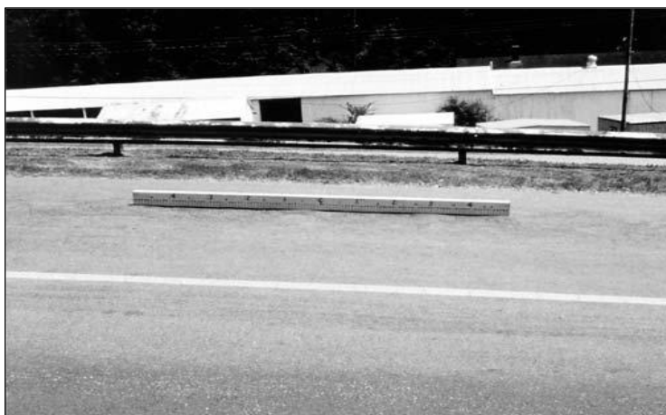
FIGURA 40: Severidad Media (M) Corrugación.
