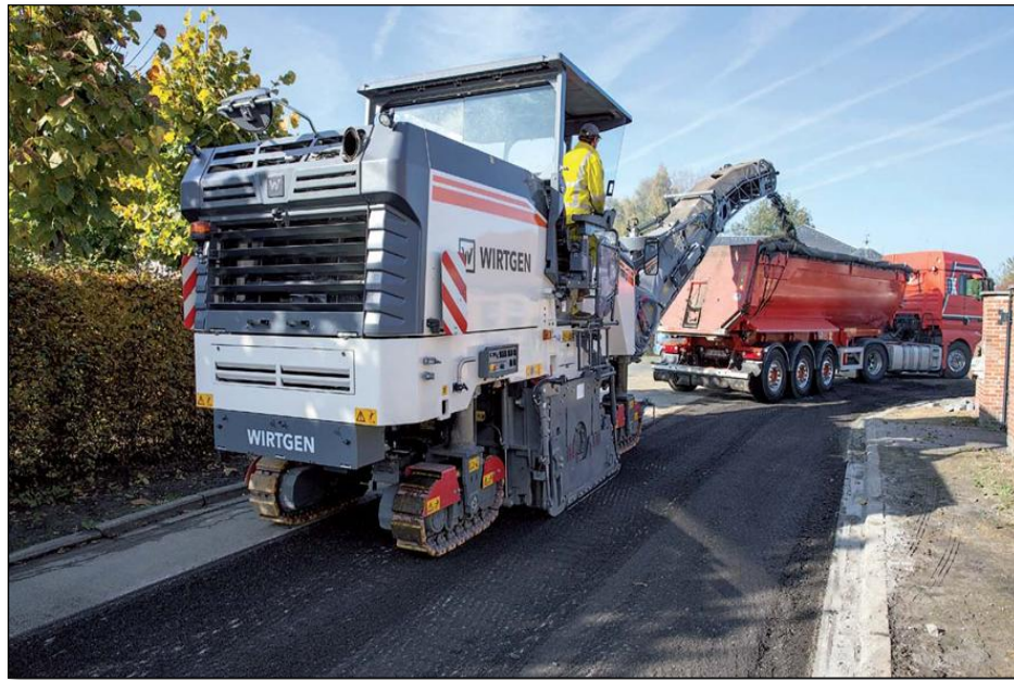
FIGURA 16: Maquina fresadora, pavimento fresado y material fresado FUENTE: Carreteras-pa, 2018
