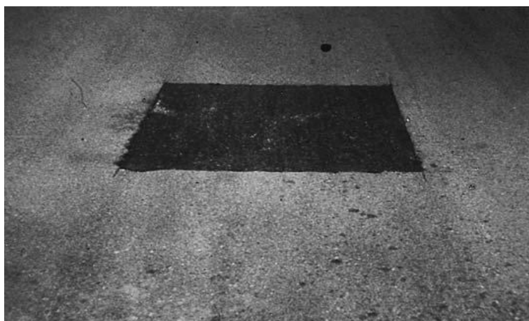
FIGURA 57: Severidad Bajo (L) de Parches y Cortes Utilitarios. FUENTE: American society for testing and materials, 2018.
