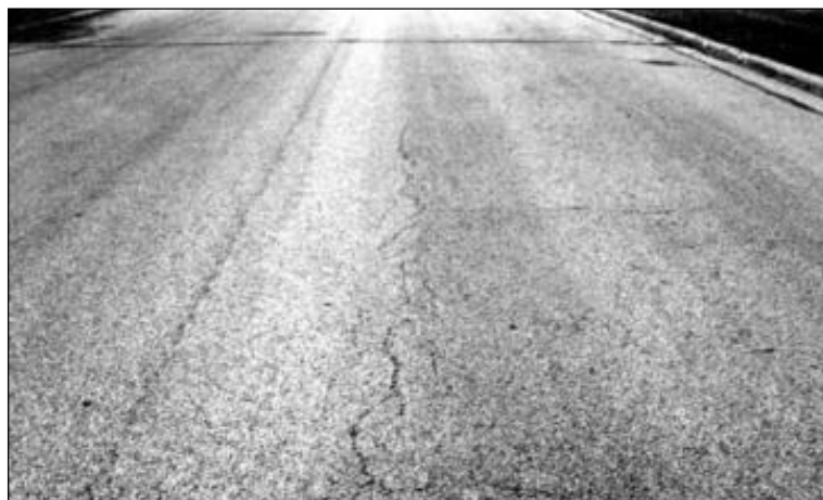
FIGURA 27: Nivel de severidad de Piel de Cocodrilo (L)
