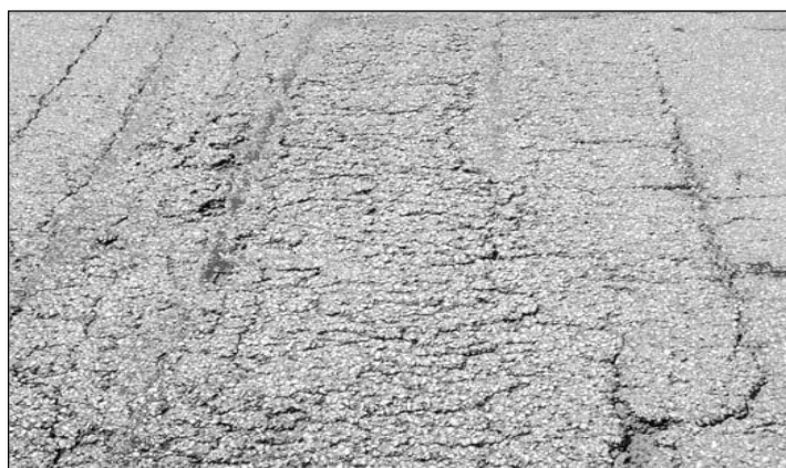
FIGURA 75: Severidad Medio (M) de Peladura por Intemperismo
