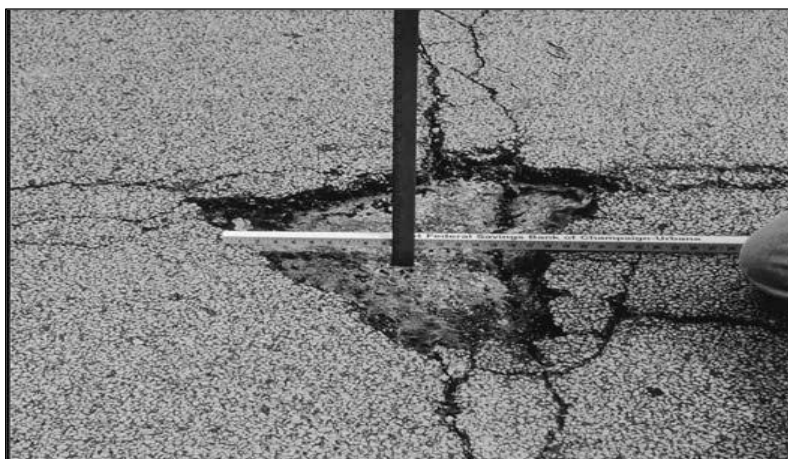
FIGURA 62: Severidad Medio (M) de Parches FUENTE: American society for testing and materials, 2018.
