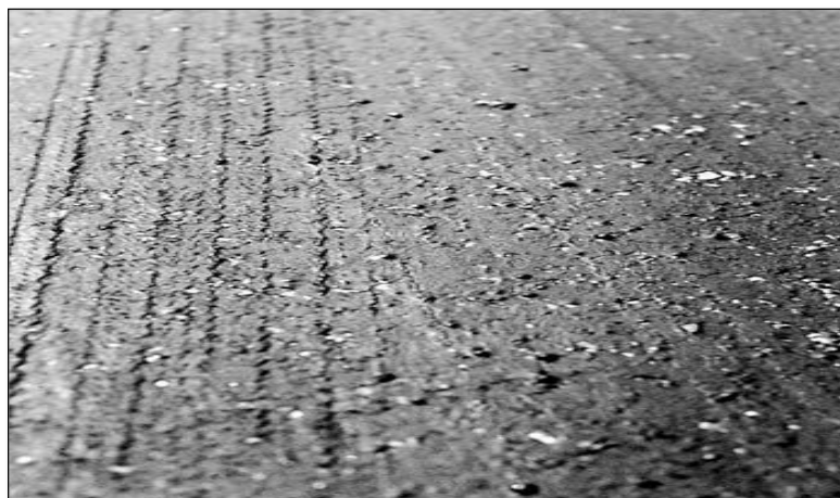
FIGURA 32: Severidad Alta (H) de Exudación.
