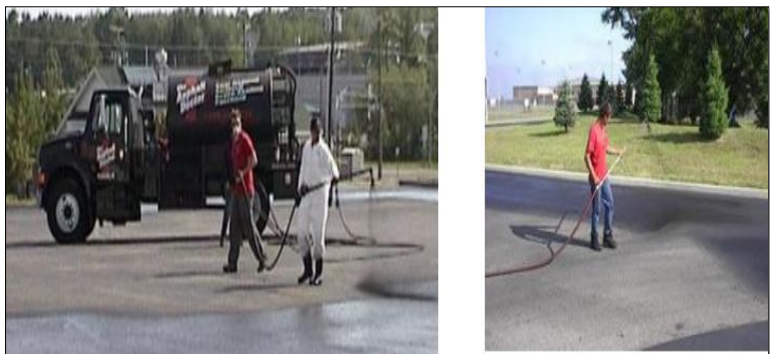
FIGURA 10 Procedimiento típico de riego negro. FUENTE: Medina & De la Cruz, 2015
