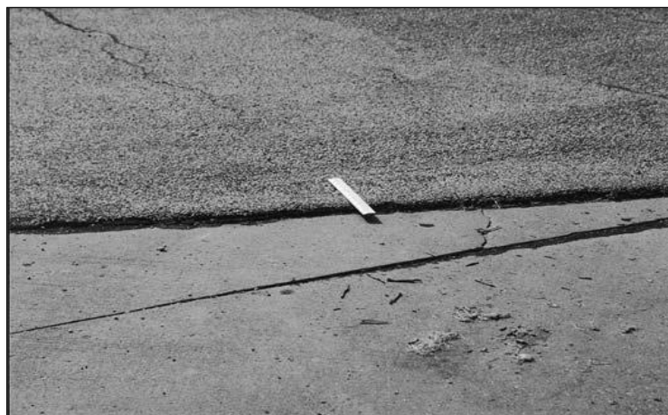
FIGURA 68: Severidad Media (M) de Desplazamiento. FUENTE: American society for testing and materials, 2018.
