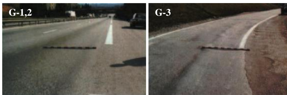
FIGURA 85: Gravedad 1,2,3; Ahuellamiento
