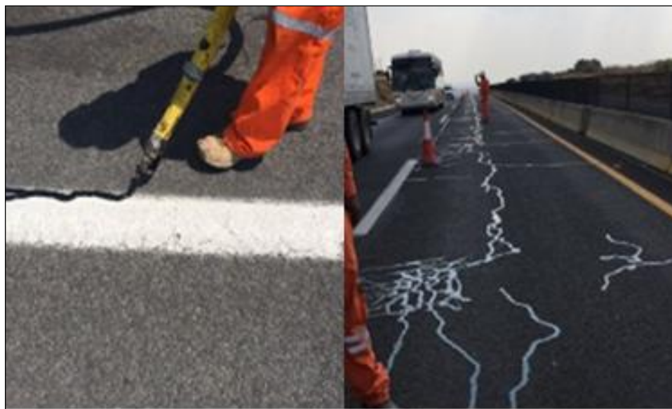
FIGURA 7: Sellado de Grietas con asfalto.
