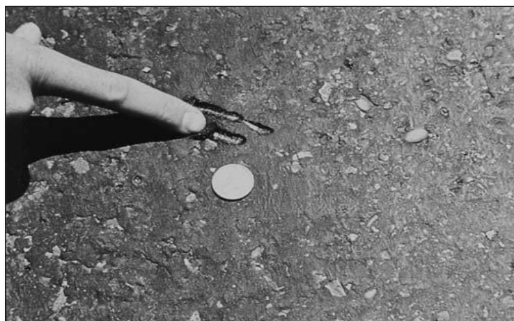
FIGURA 31: Severidad Medio de Exudación (M) FUENTE: American Society for Testing and Materials, 2018
