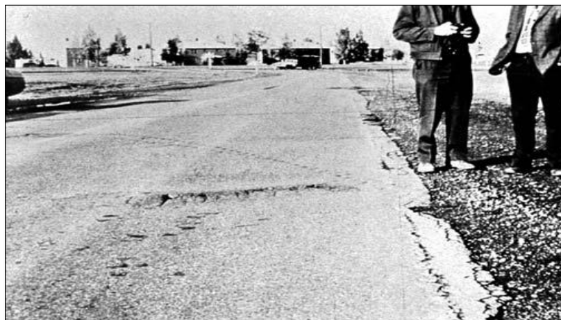
FIGURA 37: Severidad Medio(M) en Abultamientos y Hundimientos FUENTE: American society for testing and materials, 2018
