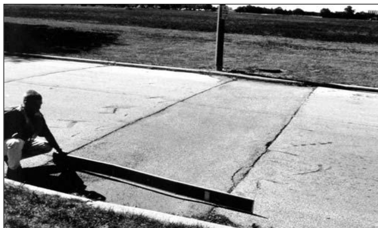
FIGURA 58: Severidad Medio (M) de Parches y Cortes Utilitarios. FUENTE: American society for testing and materials, 2018.
