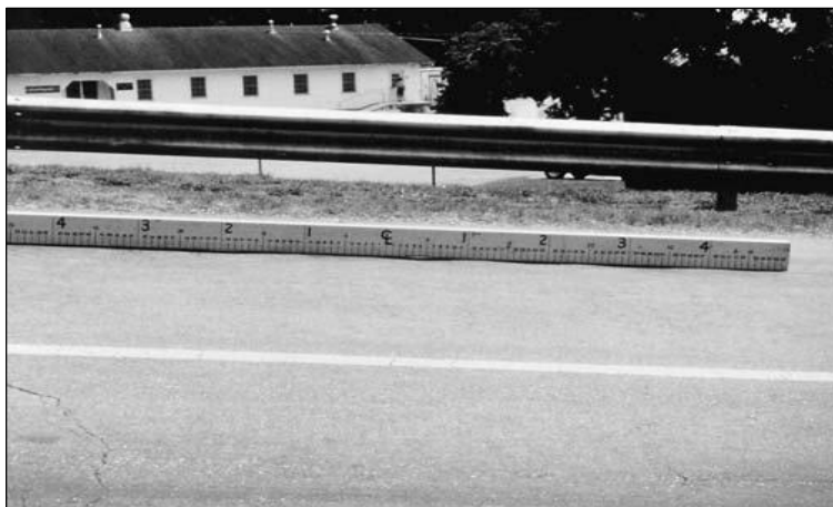
FIGURA 39: Severidad Bajo (L) Corrugación.
