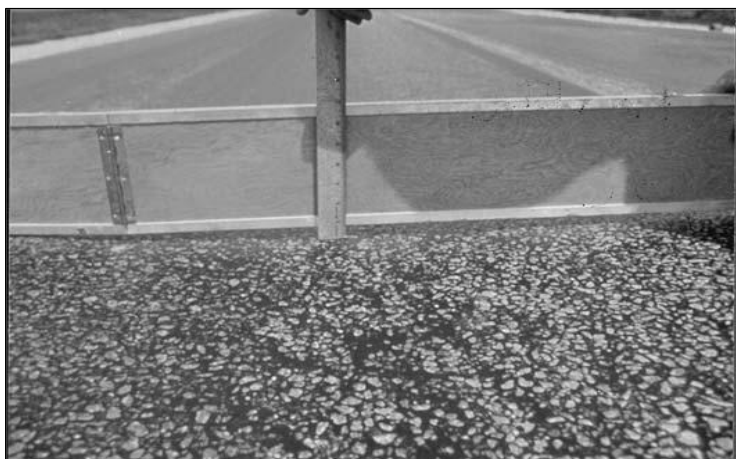
FIGURA 65: Severidad Medio (M) de Ahuellamiento. FUENTE: American society for testing and materials, 2018.
