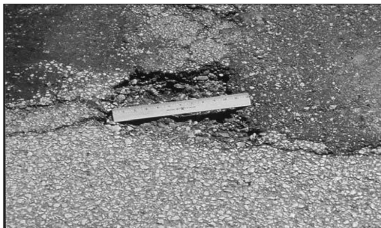
FIGURA 61: Severidad Bajo (L) de Parches FUENTE: American society for testing and materials, 2018.
