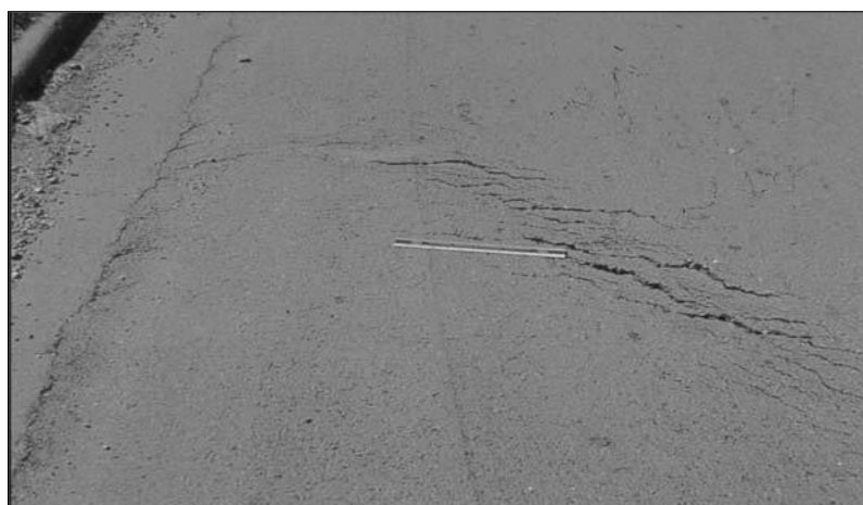
FIGURA 71: Sev. Medio (M) de Fisuras Parabólicas por Deslizamiento FUENTE: American society for testing and materials, 2018.
