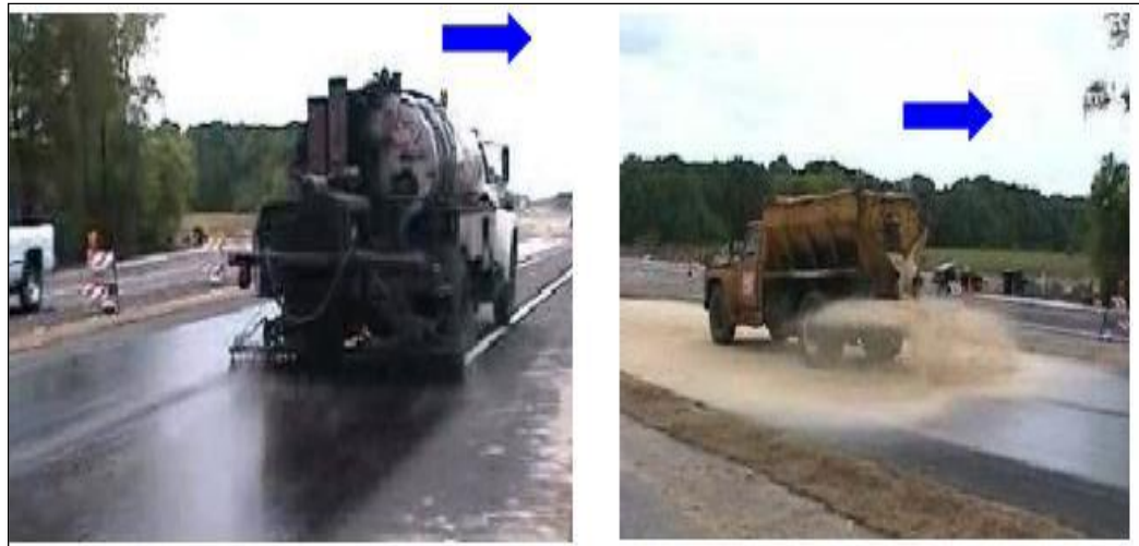
FIGURA 9: Procedimiento típico sello arena-asfalto FUENTE: Medina & De la Cruz, 2015
