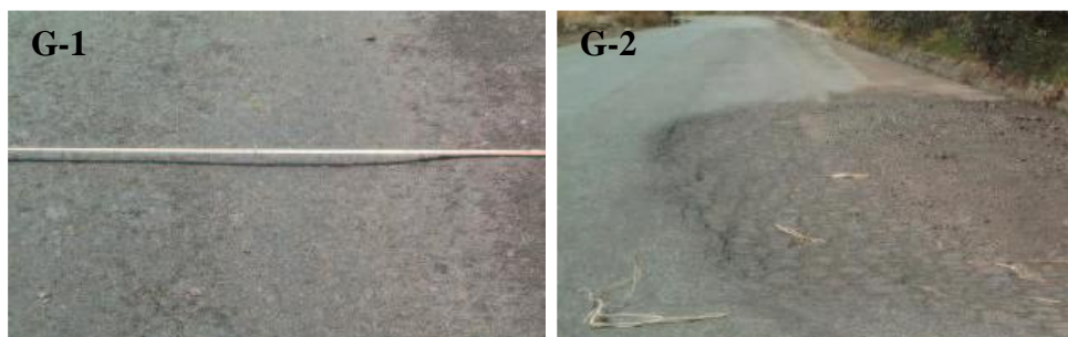
FIGURA 84: Magnitud de Falla, depresiones localizadas(hundimiento).
