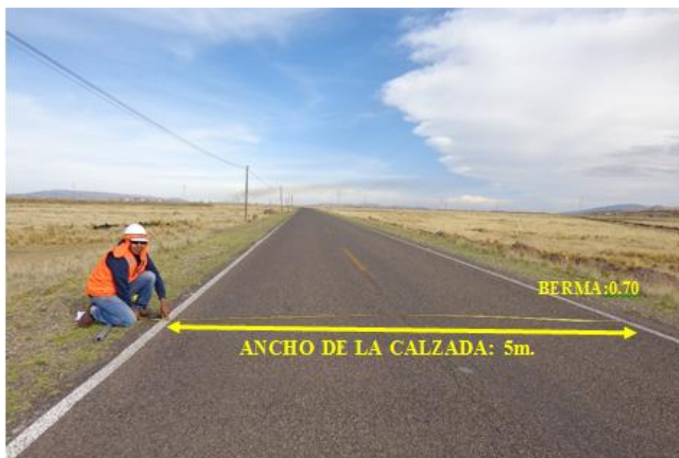
FIGURA 99: Dimensión de calzada y berma
