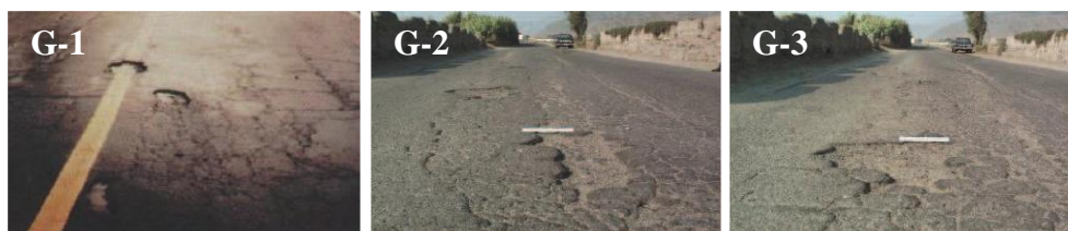
FIGURA 88: Gravedad 1, 2,3; Baches (Huecos)
