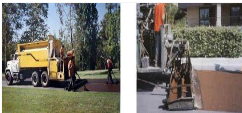
FIGURA 12: Aplicación de lechada asfáltica y micro aglomerante en frío. FUENTE: Medina & De la Cruz, 2015
