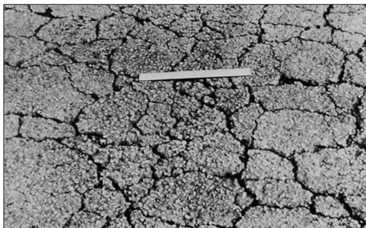
FIGURA 29: Severidad Alta de Piel de Cocodrilo (H) FUENTE: American Society for Testing and Materials, 2018
