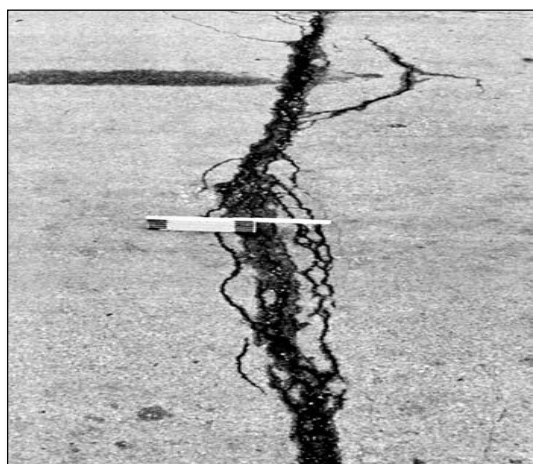
FIGURA 50: Severidad Alto (H) de Fisuras de Reflexión de Junta FUENTE: American society for testing and materials, 2018.
