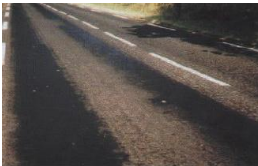
FIGURA 90: Gravedad 3 ; Continua con Superficie Viscosa
