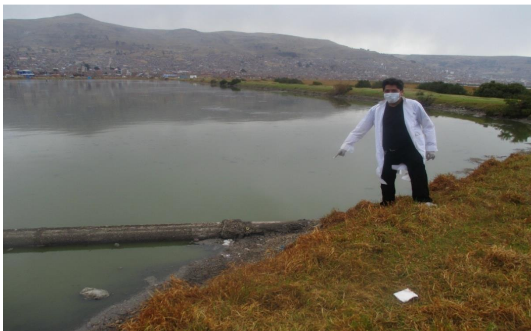
2. Isla Espinar, ingreso de aguas residuales.
