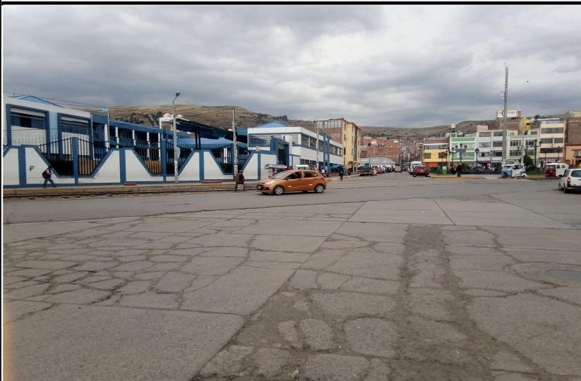
Toda la superficie del pavimento de la interseccion se encuentra en mal estado con grietas de gran tamaño
