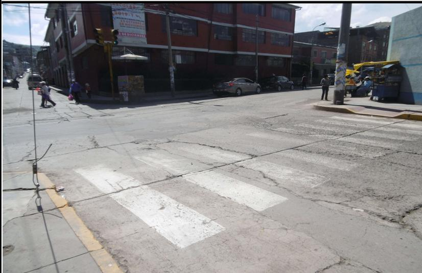
El pavimento se muestra deteriorado con grietas de gran tamaño
