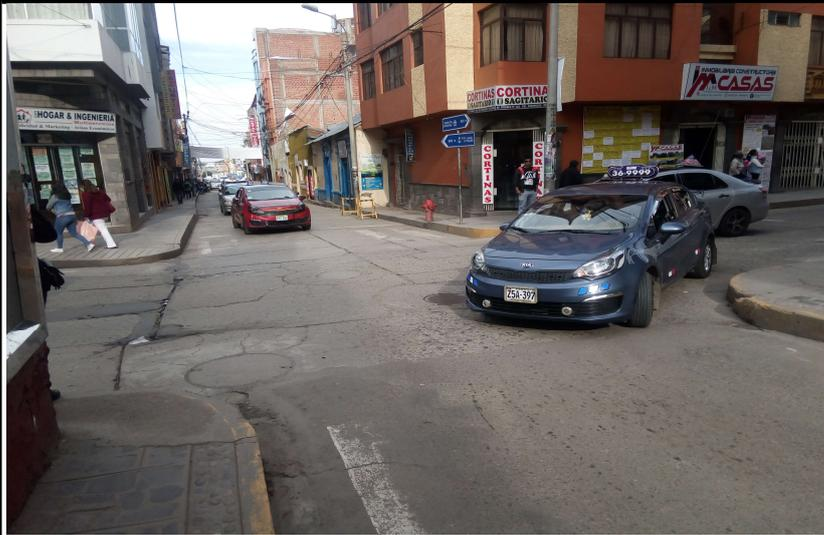
Superficie irregular con baches y superficie de rodadura desgastada y no existe rampas para discapacitados
