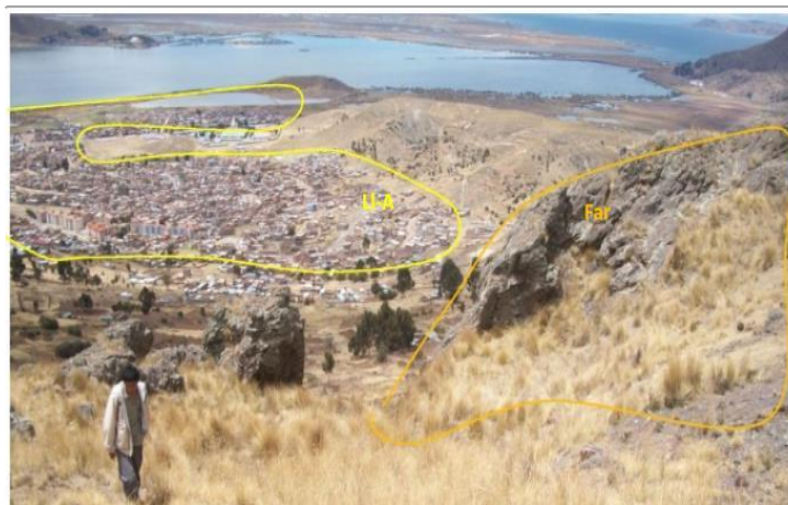
FIGURA 20 CANCHARANI ZONA DE DESPRENDIMIENTO DE BLOQUES DE ROCA.
