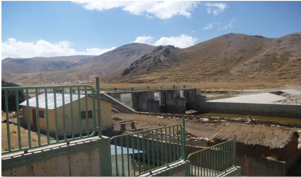
Figura 14. Punto N° 1 Zona de la bocatoma I.
