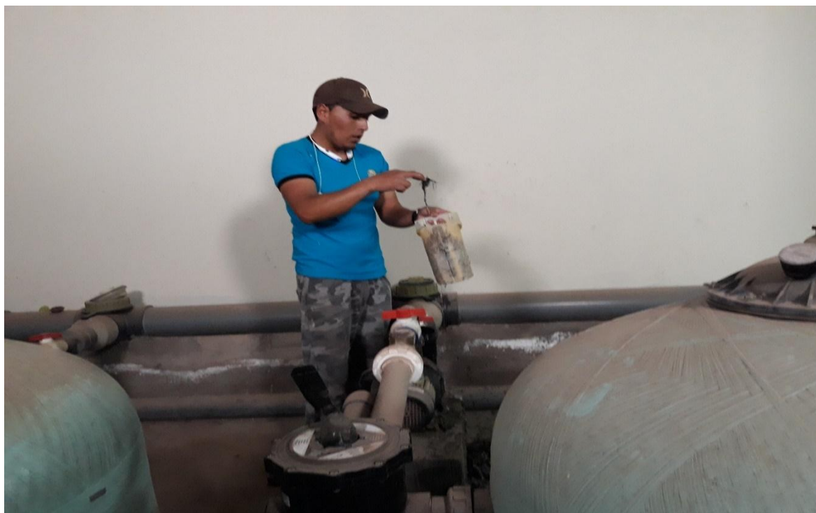
Figura 30. Observacion del filtro del sistema de recirculacio como este retiene los pelos, entre otros, julio – noviembre del 2018.
