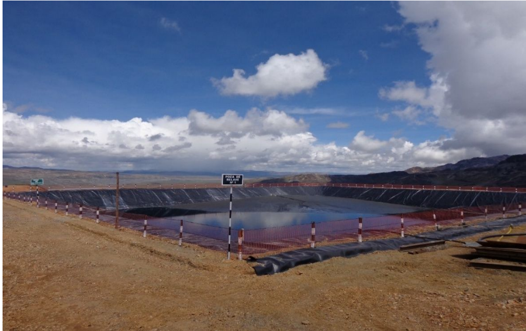
FIGURA N° 17: Fotografía de la poza relavera de la Planta Actual
