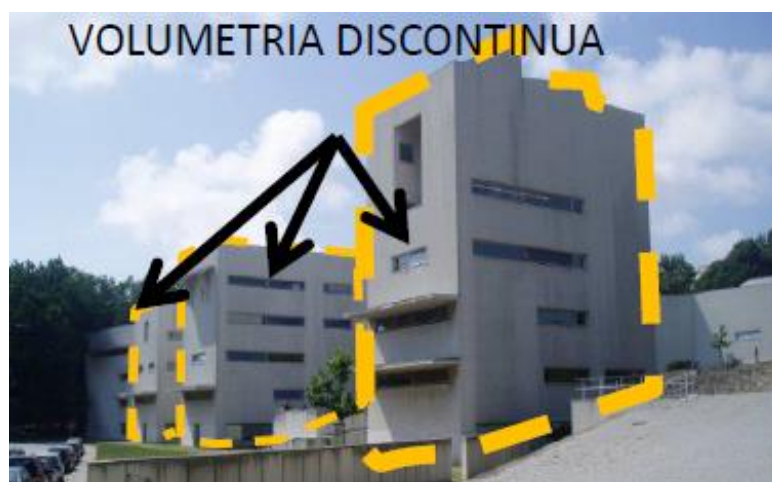
Figura 27: vista frontal de área académica
