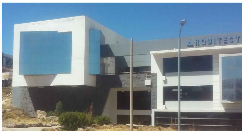
Figura 39: Edificación existente de la E.P. de Arquitectura y urbanismo - UNAP Fuente: Elaboración Propia
