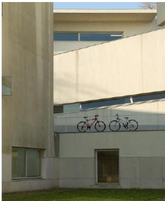
Figura 29: Estructura de hormigón - Facultad de arquitectura de porto.
