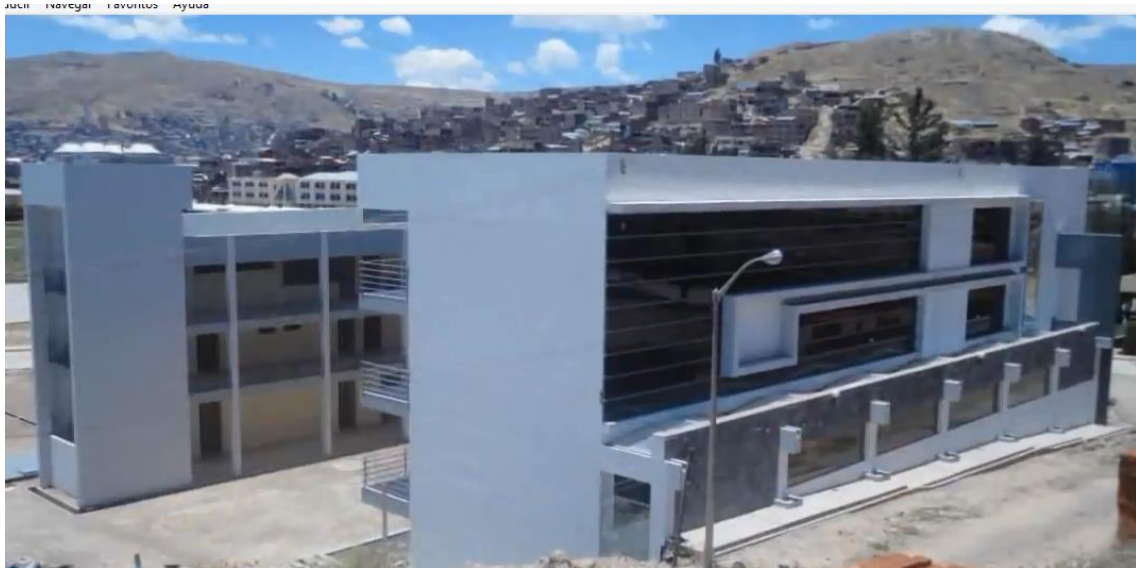
Figura 40: Edificación existente de la E.P. de Arquitectura y Urbanismo - UNAP Fuente: Elaboración Propia
