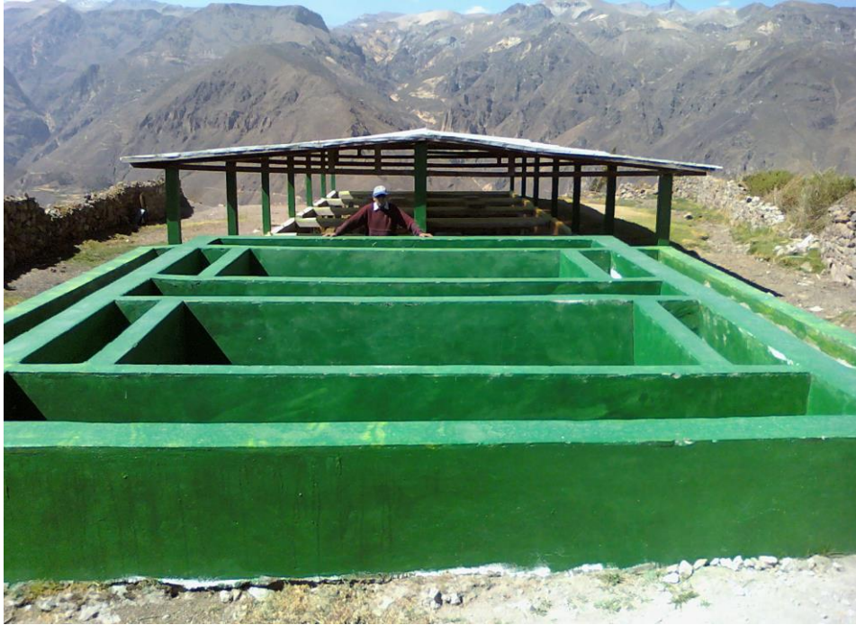
Figura 18. Sistema de tratamiento de agua residual etapa primaria y secundaria con cubierta para las bajas temperaturas.
