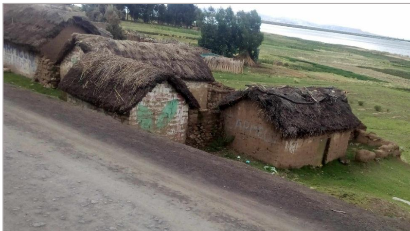
Figura 57: Vivienda típica de la zona circunlacustre. Propia de los autores.
