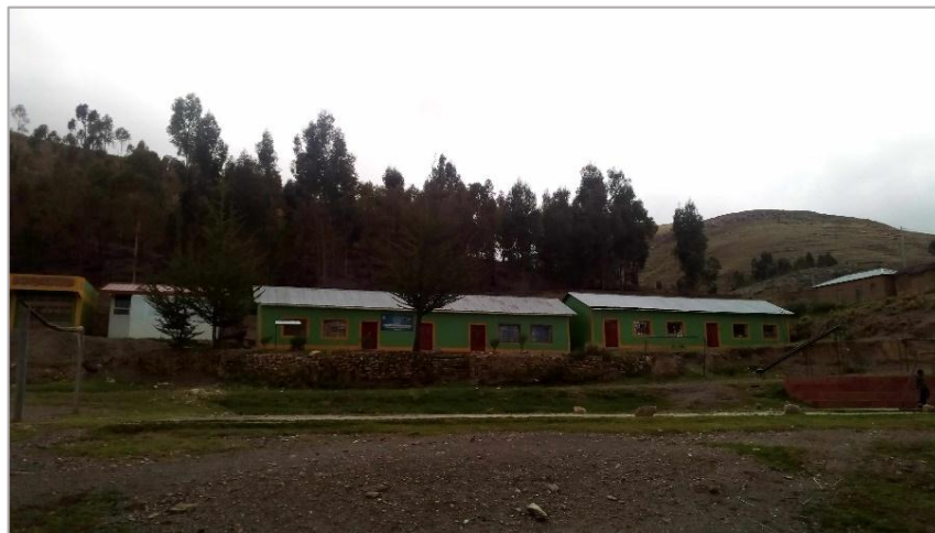
Figura 56: Escuela de Umansaya Propia de los autores.
