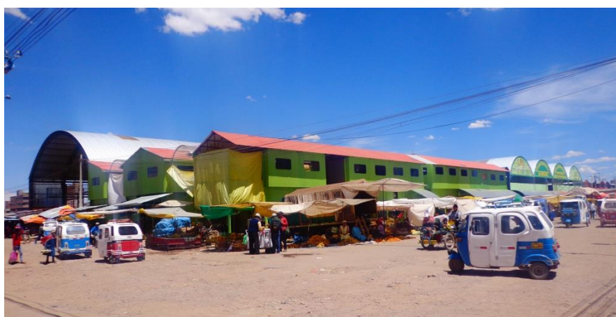
FIGURA 1.4: Infraestructura del mercado Las Mercedes
