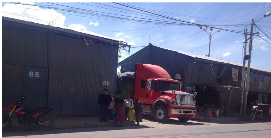
FIGURA 1.3: Accesibilidad no adecuada vehicular y peatonal
