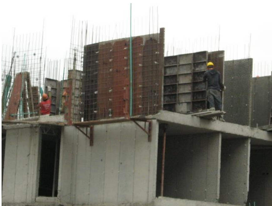
FIGURA 5.27: Colocación con guía de concreto prefabricado
