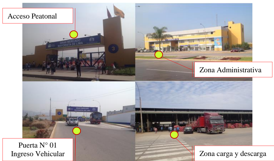
FIGURA 2.23: Volumetría y emplazamiento del Mercado Mayorista FUENTE: Elaboración propia (fotografía in situ)
