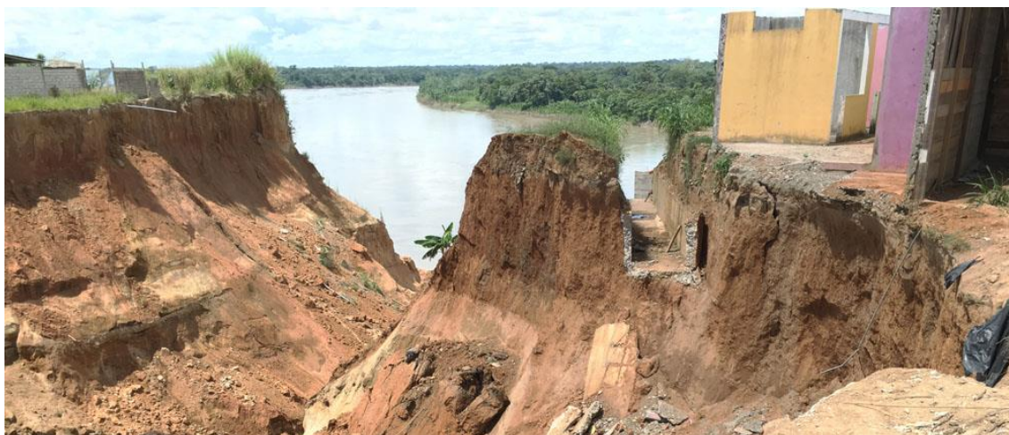
Figura 53: Deslizamientos en los bordes de los ríos.
