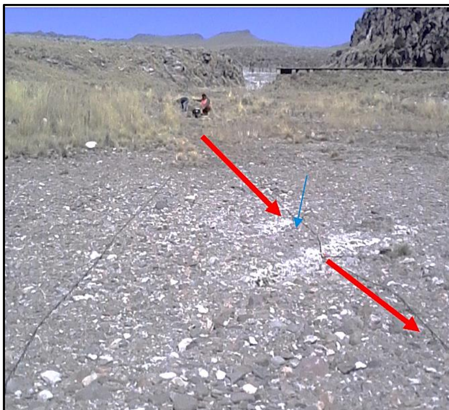
Foto 1: Líneas Sísmicas Instaladas
