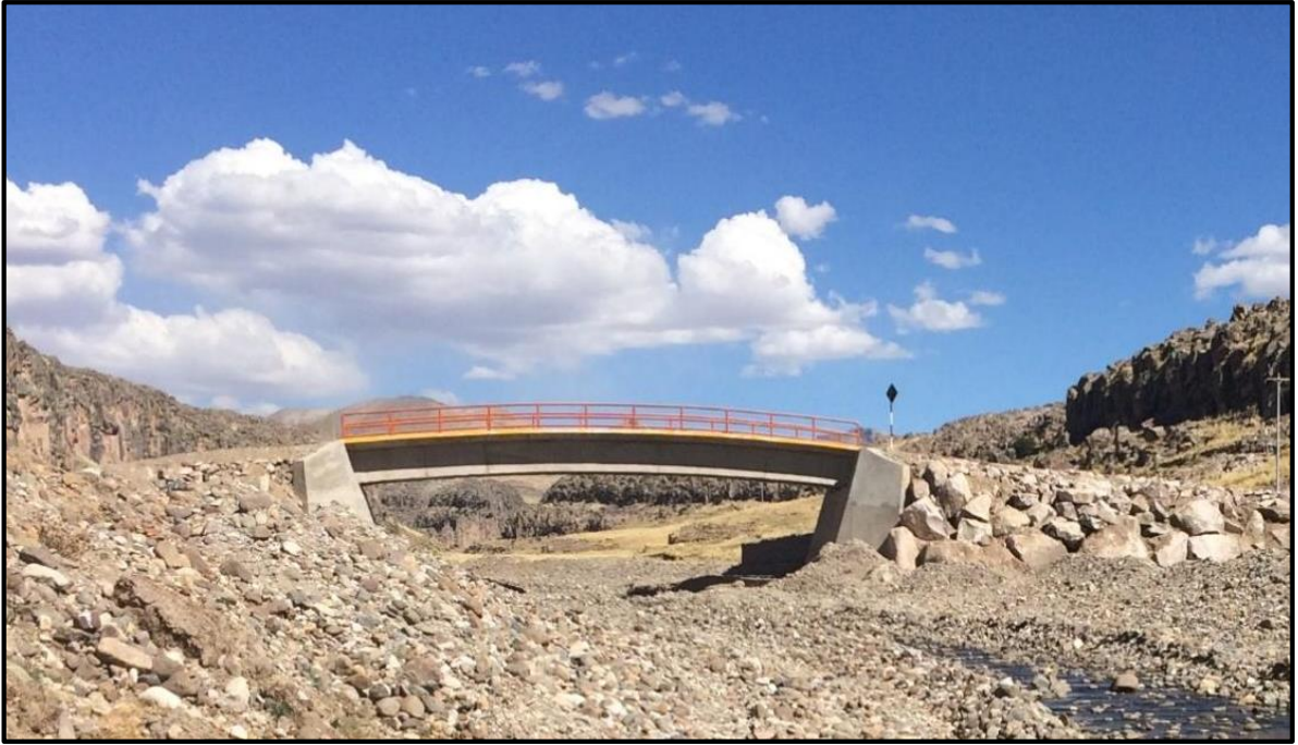
Foto 3: Vista del Puente Existente
