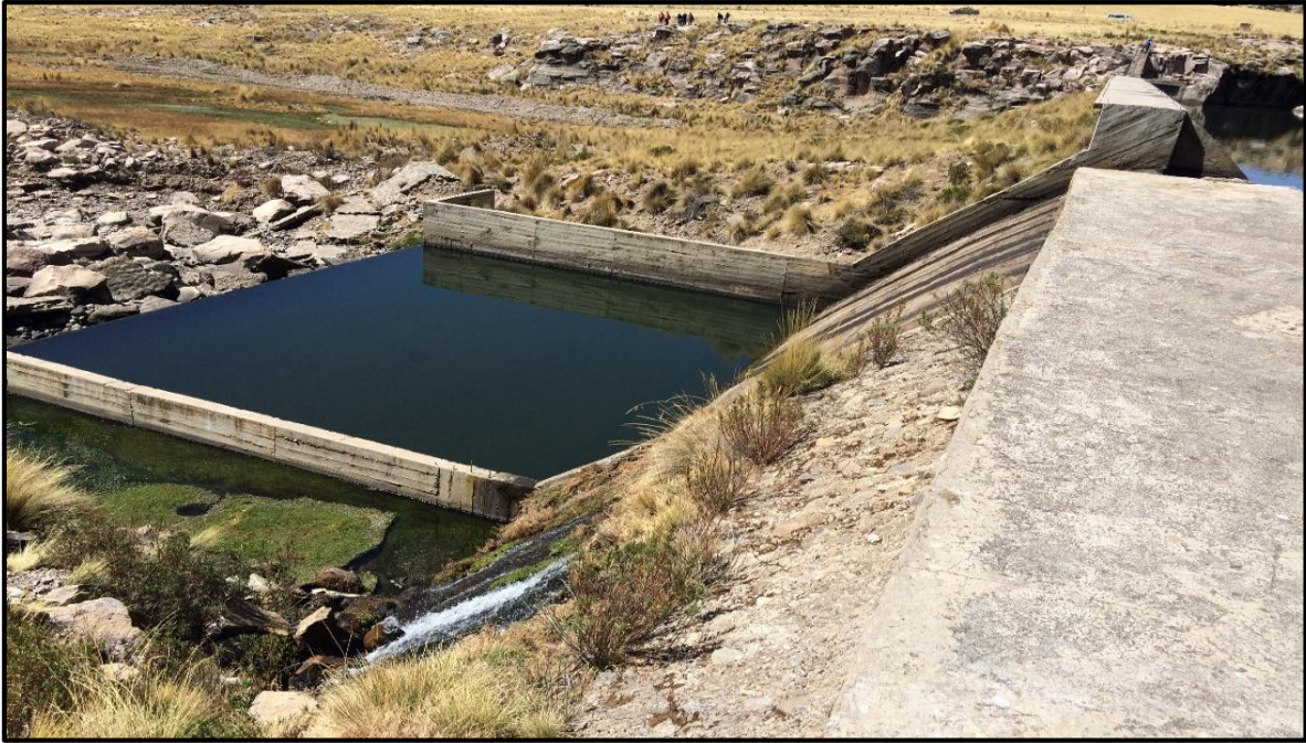
Foto7: Compuerta del canal de descarga de la presa existente
