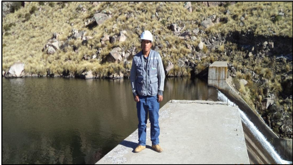
Foto 1: Vista general de la presa existente
