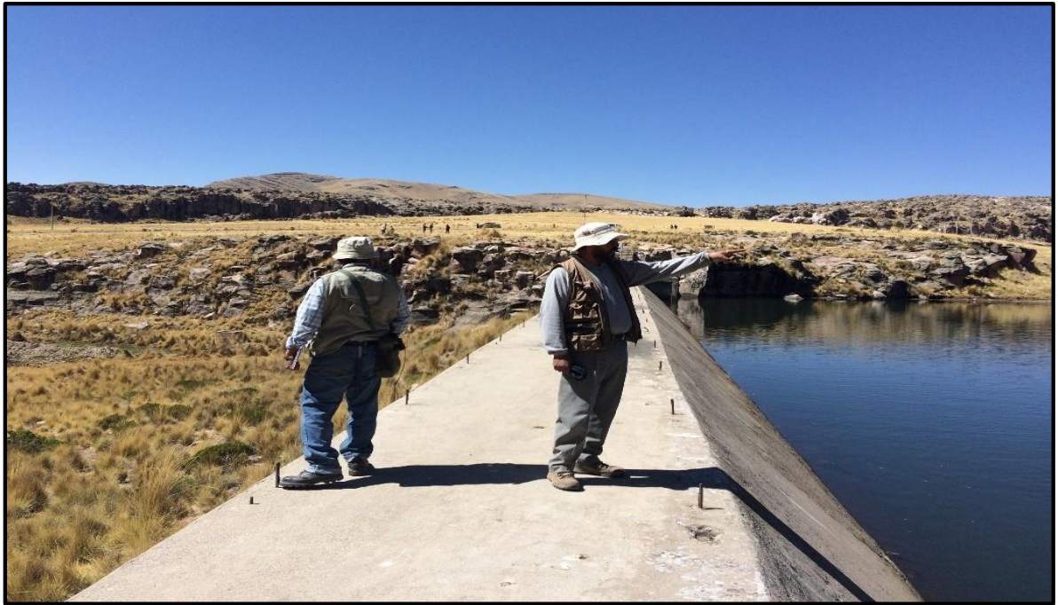
Foto 5: Especialista en Hidráulica y el Especialista en Geotecnia evaluando la Presa Existente
