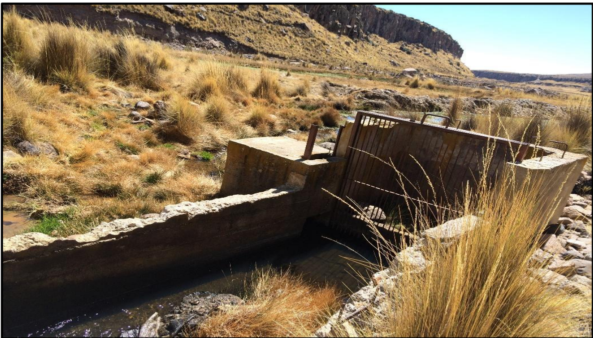
Foto 8: Infraestructura existente del vertedero de descarga de la PRESA HUAYLLUMAYO
