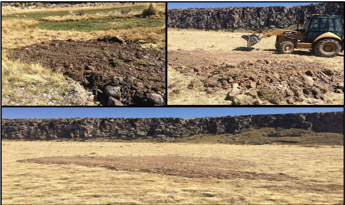
Foto 20: Reposición de suelos de las Calicatas
