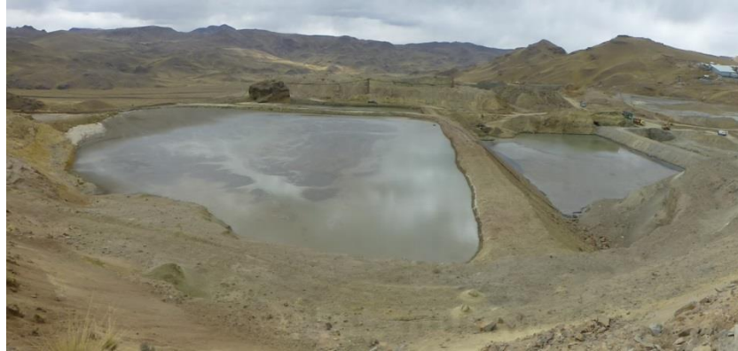
FOTO No 4: Contenedor de relaves en el tajo U.M. Tacaza
