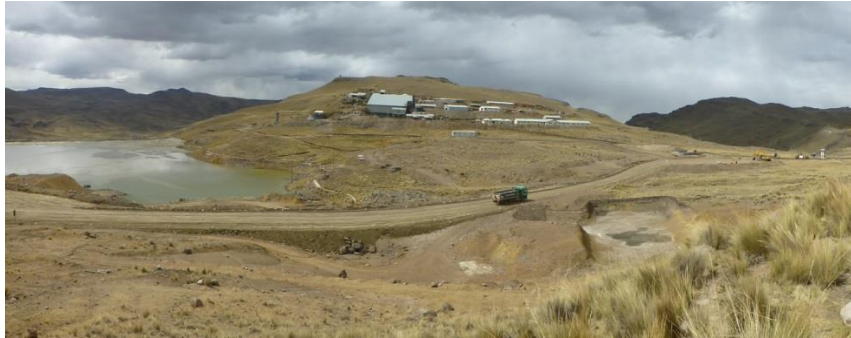
FOTO No 1: Planta concentradora U.M. Tacaza
