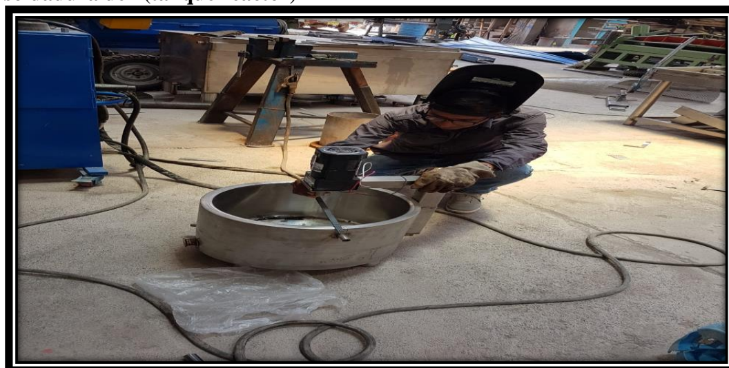
Imagen 3. Proceso de constructivo del equipo de tratamientos aplicado la soldadura del (tanque reactor)
