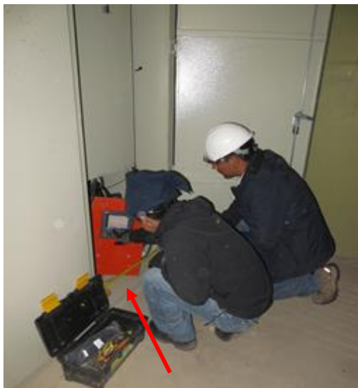
FOTO 12.- Instalación y montaje de Medidor de energía y de calidad de energía PowerLogic ION 7650 en celdas
