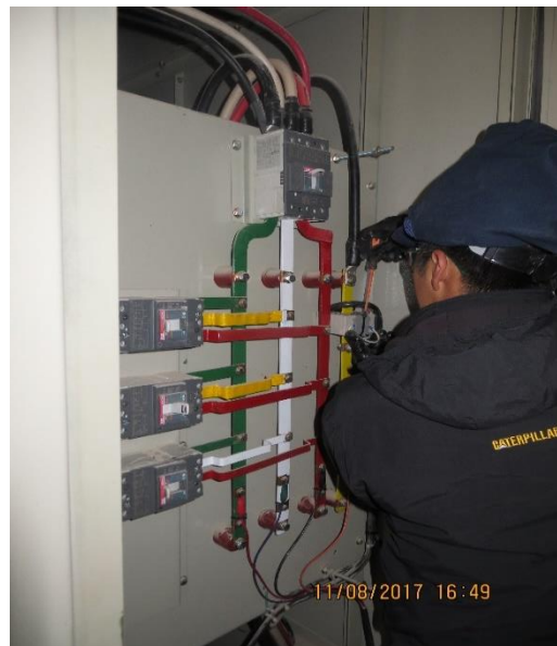
FOTO 13.- Instalación y montaje de Transformadores de Corriente
