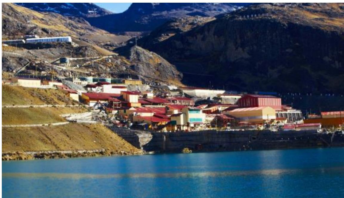
Figura 1: Vista planta concentradora UM San Rafael
