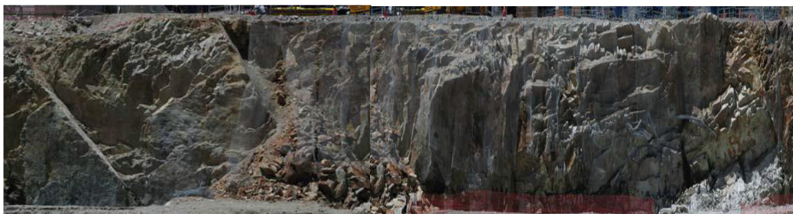
Figura N° 24: Estado inicial del muro “R”
