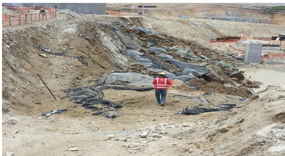
Figura N° 53: Escombros de voladura con una fragmentación excavable
