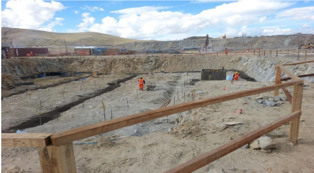
Figura N° 60: Taludes estables en el contorno de cimentaciones
