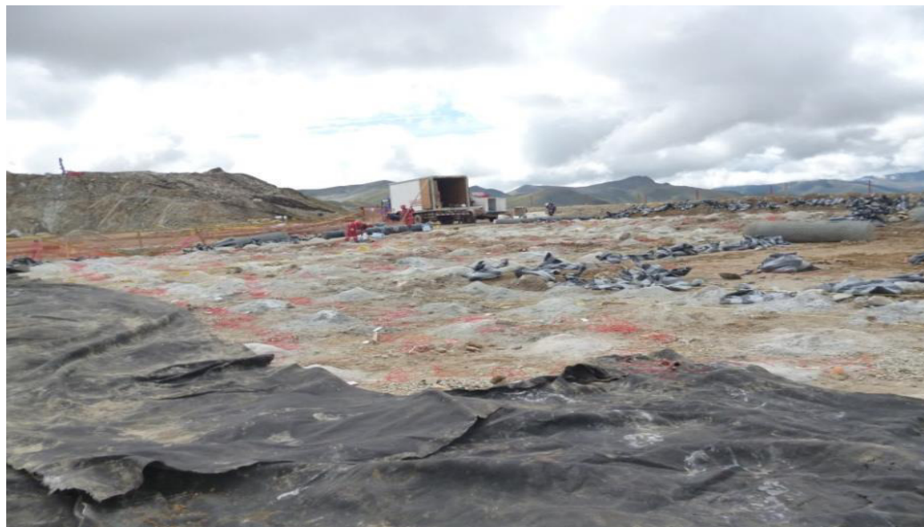
Figura N° 58: Zona de voladura recubierta
