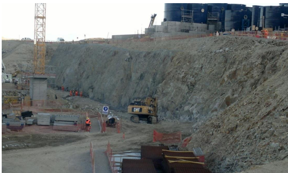
Figura N° 55: Estabilidad del Muro “R”, tras la voladura
