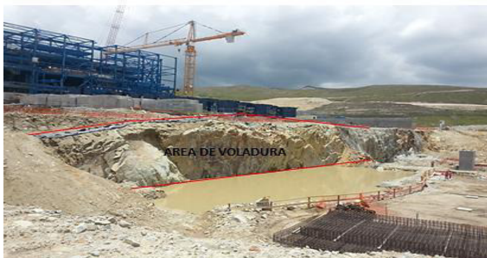
Figura N° 51: Zona de voladura del muro R
