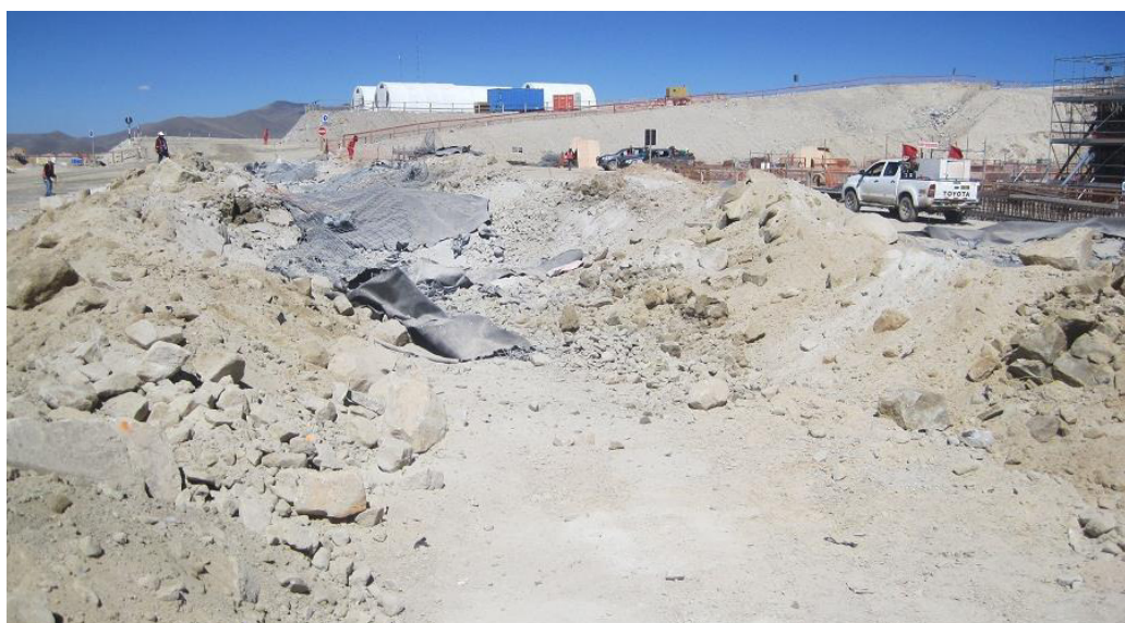
Figura N° 63: Pila de escombros tras la voladura.
