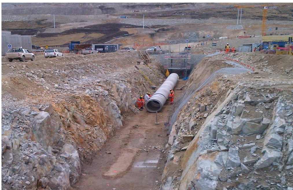
Figura N° 65: Estabilidad de taludes en el contorno de la zanja.
