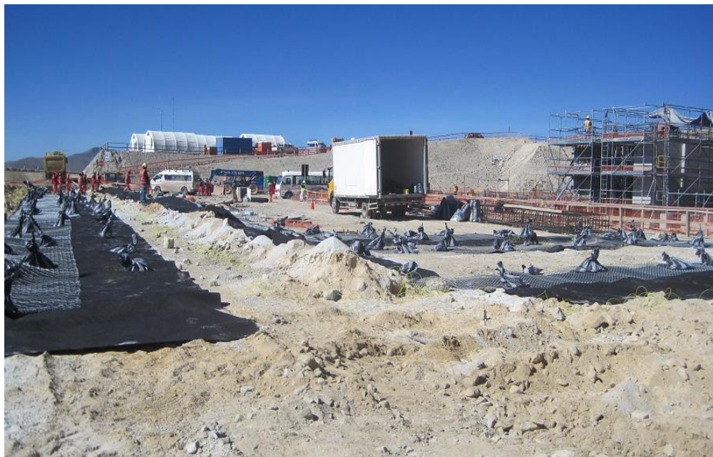
Figura N° 62: Zona de voladura de zanjas recubierta
