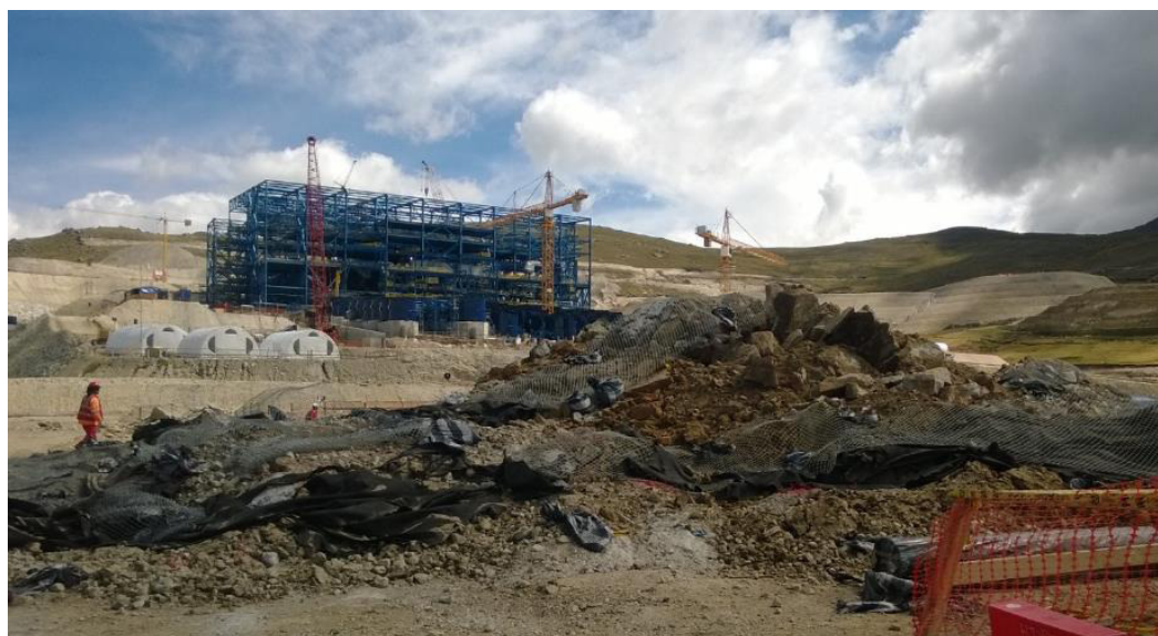
Figura N° 59: Pila de escombros de la voladura de cimentaciones
