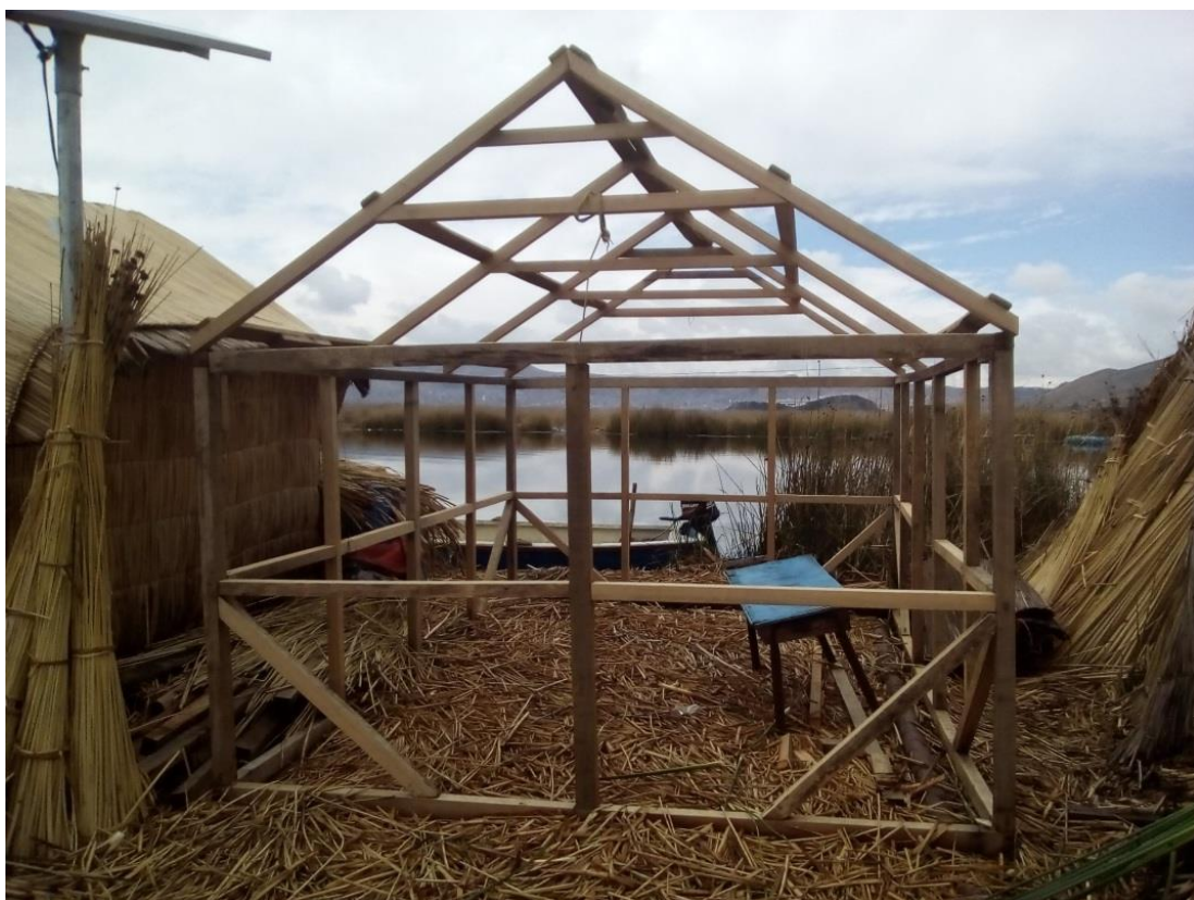
Construcción de una casa.
