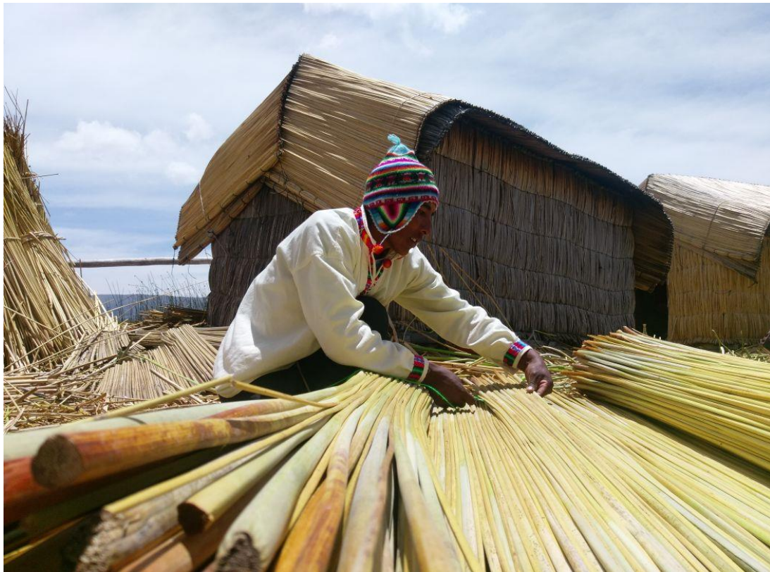
Elaboración de un techo de totora para la casa.
