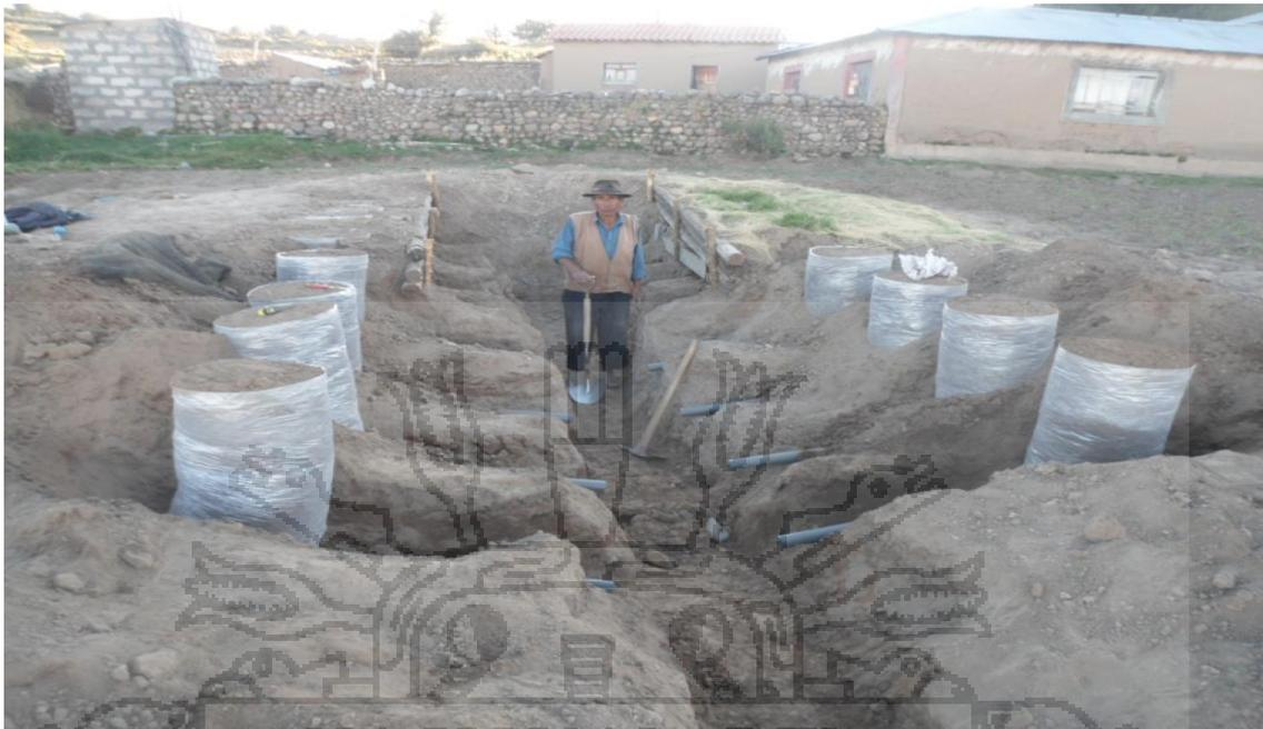
Foto 01. Instalación de Lisímetros
