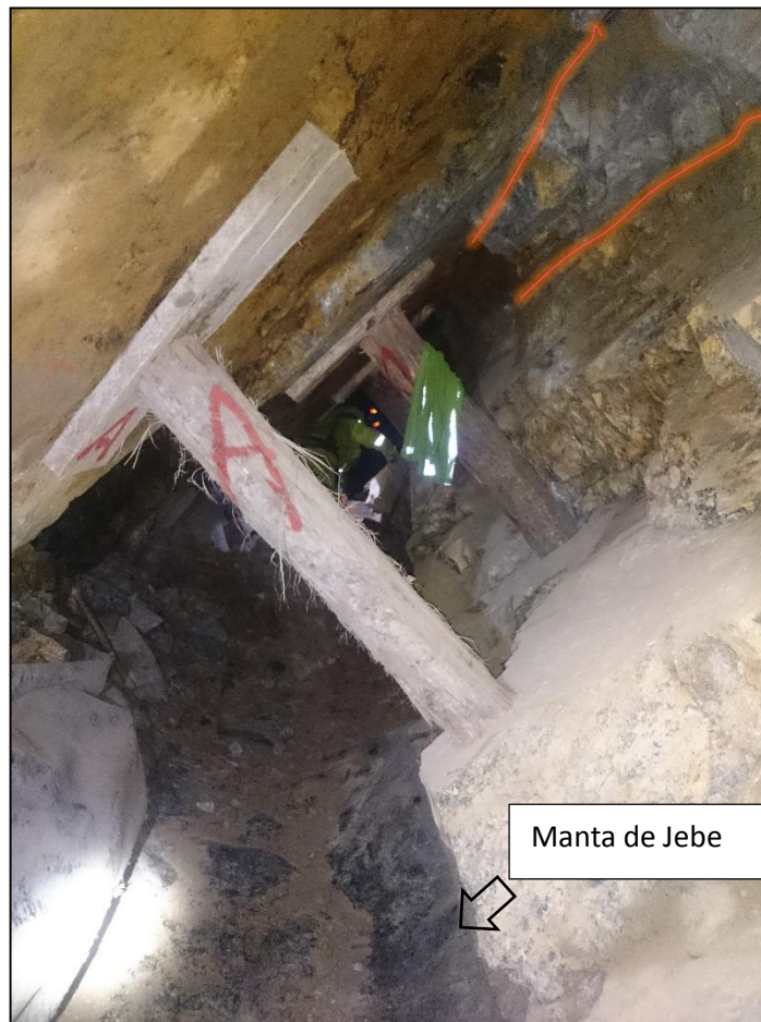
Figura N° 18. Control de calidad en labores
