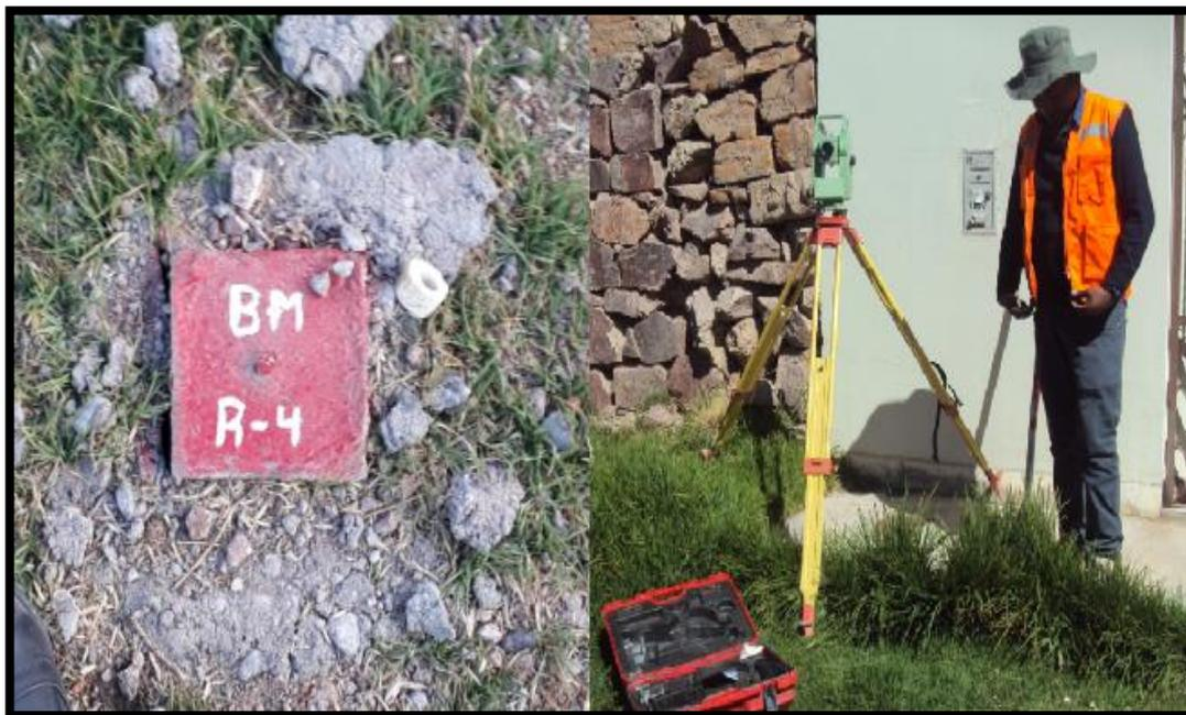
*Figura 36: BM del Reservorio R4 y equipo de levantamiento estación total.*
