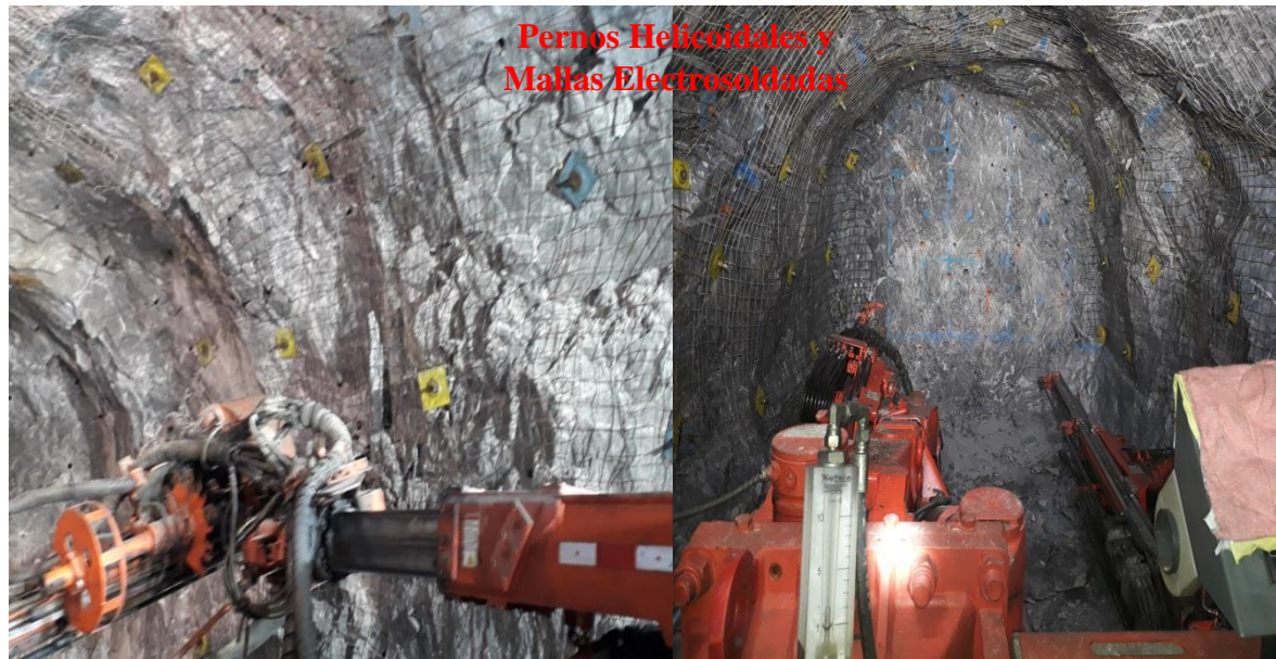
Figura 2.17 Sostenimiento mecanizado de pernos y mallas
