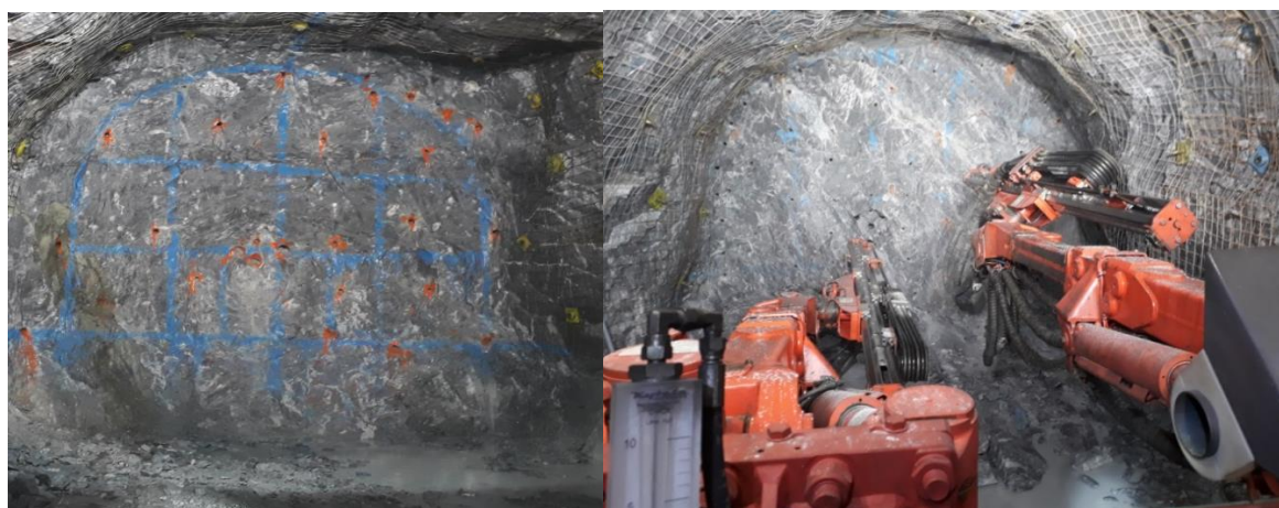
Figura 3.4 Marcado de malla para perforar con Jumbo Sandvik DD321.
