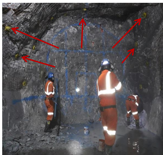
Figura 2.16 Frente de perforación sostenido con pernos helicoidales
