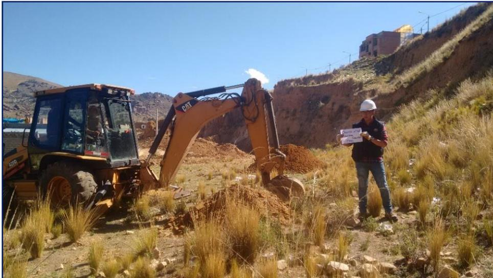
**Figura 3.17:** *Excavación y extracción de material con retroexcavadora. (Calicata N°1-2-3-4)*
