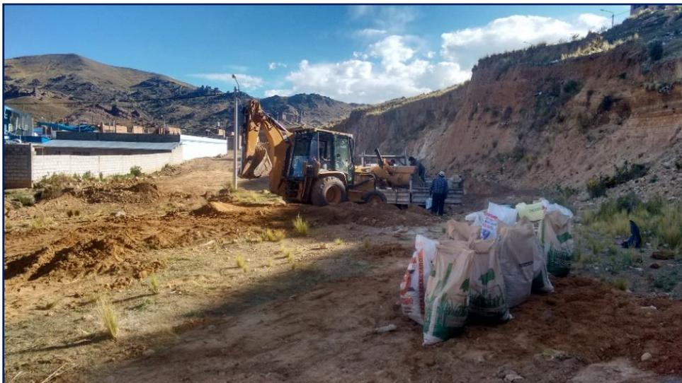
**Figura 3.18:** *Carguío de material extraído para realización de ensayos en laboratorio.*
