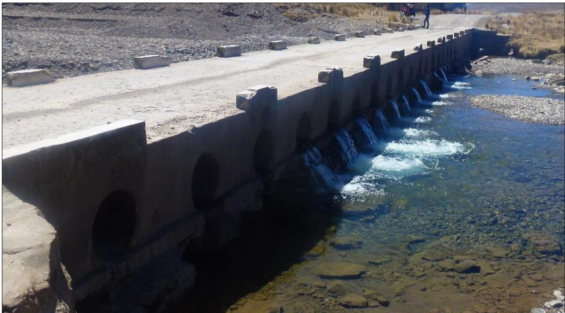
Figura 6: Vista cimentación del puente existente.
