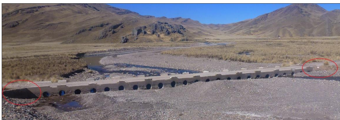
Figura 5: Vista de los aleros del puente existente.
