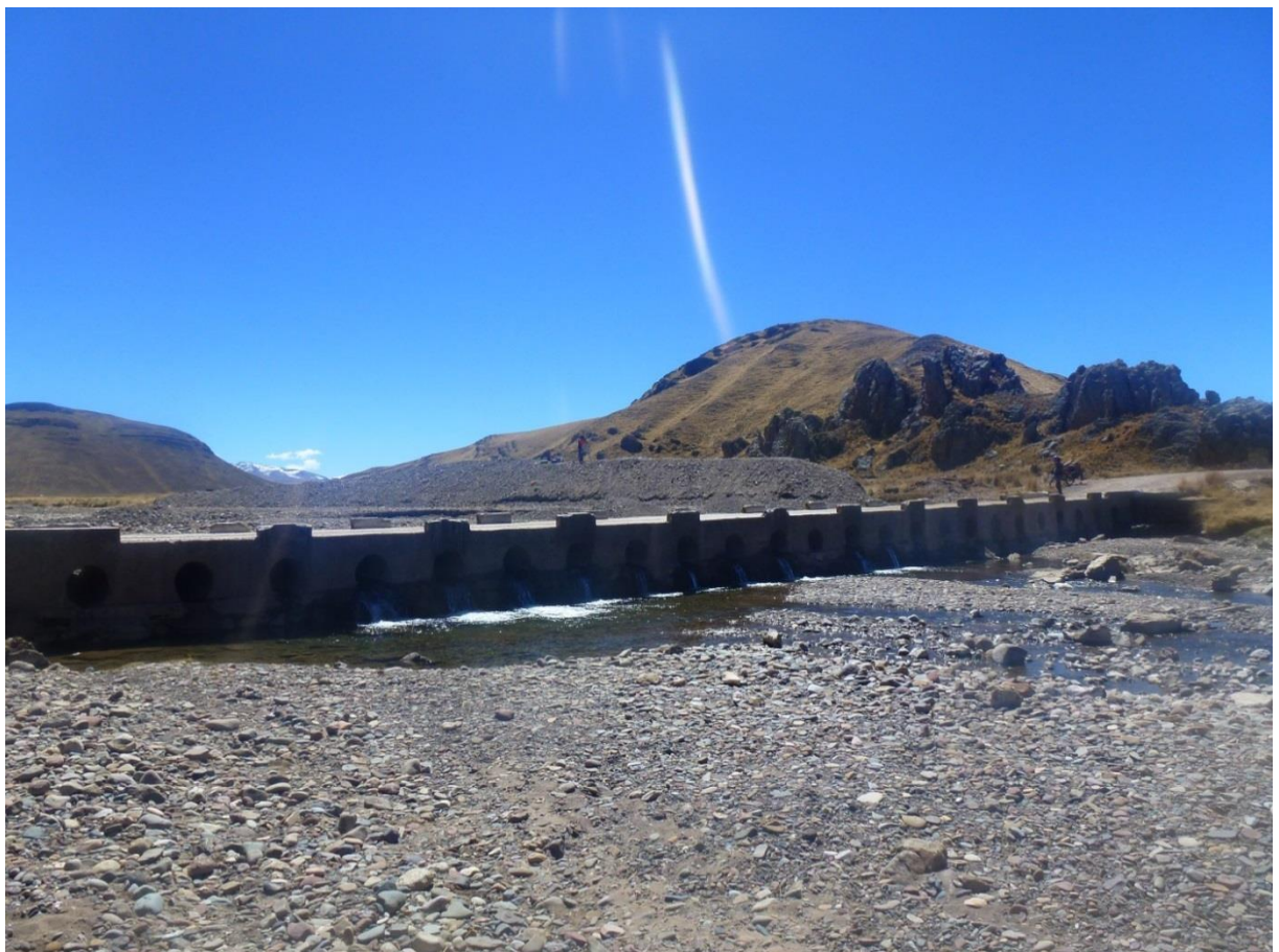
Figura 3: Estado actual del puente.
