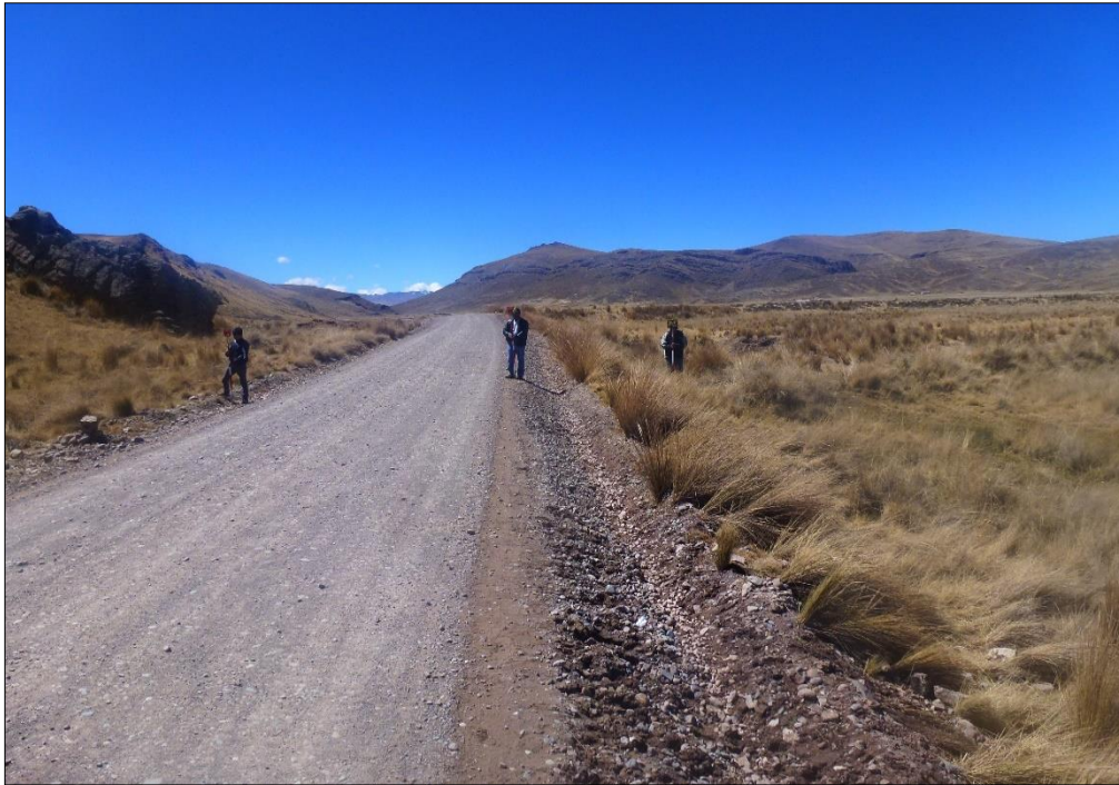
Figura 10: Vista de la carretera margen Izquierdo.
