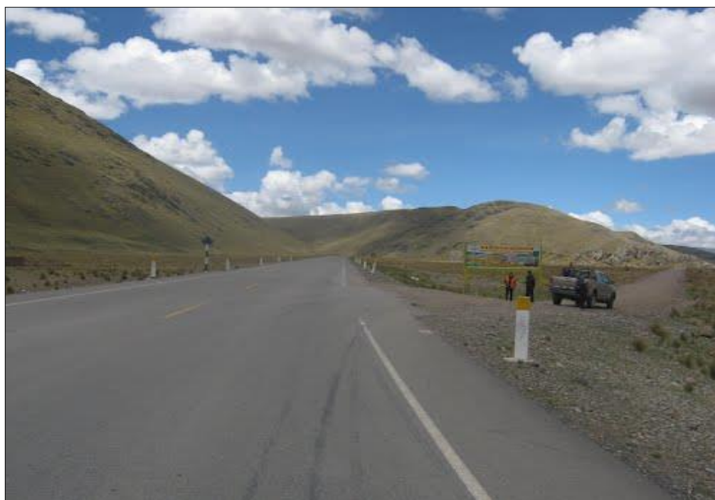
Figura1: Se muestra el inicio de la vía Emp. PE-34B (Rosario) km 0+000.00.
