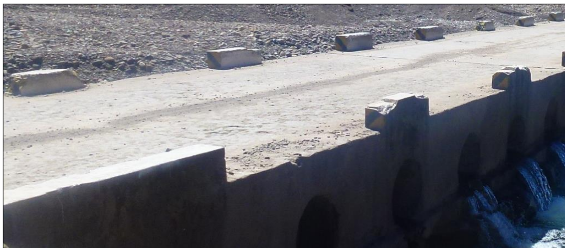
Figura 4: Vista de la losa del puente existente.
