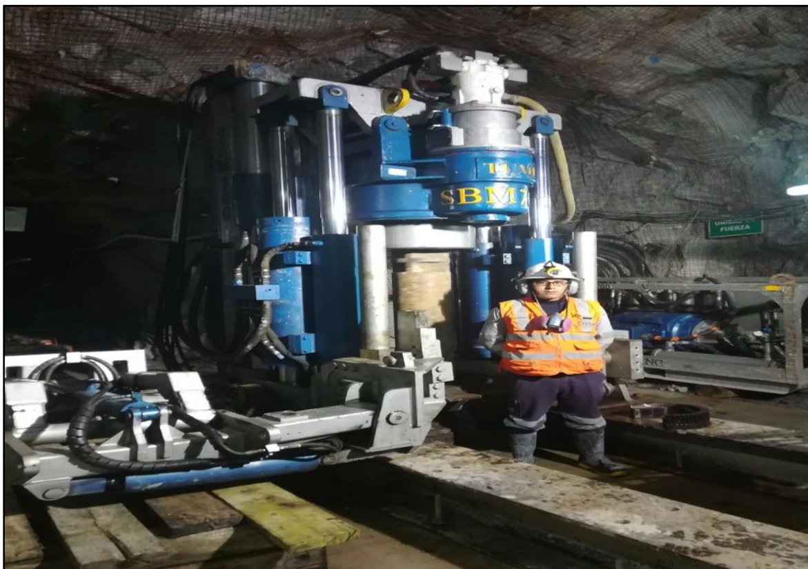
Figura N° 5. Máquina Raise Borer - SBM 700 en proceso de ejecución del taladro piloto FUENTE: Elaboración propia
