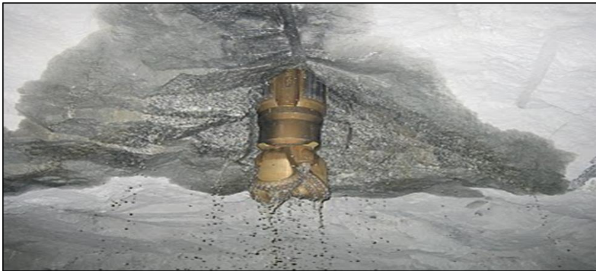
Figura 2.8. Instalación de las tuberías de perforación FUENTE: Elaboración propia
