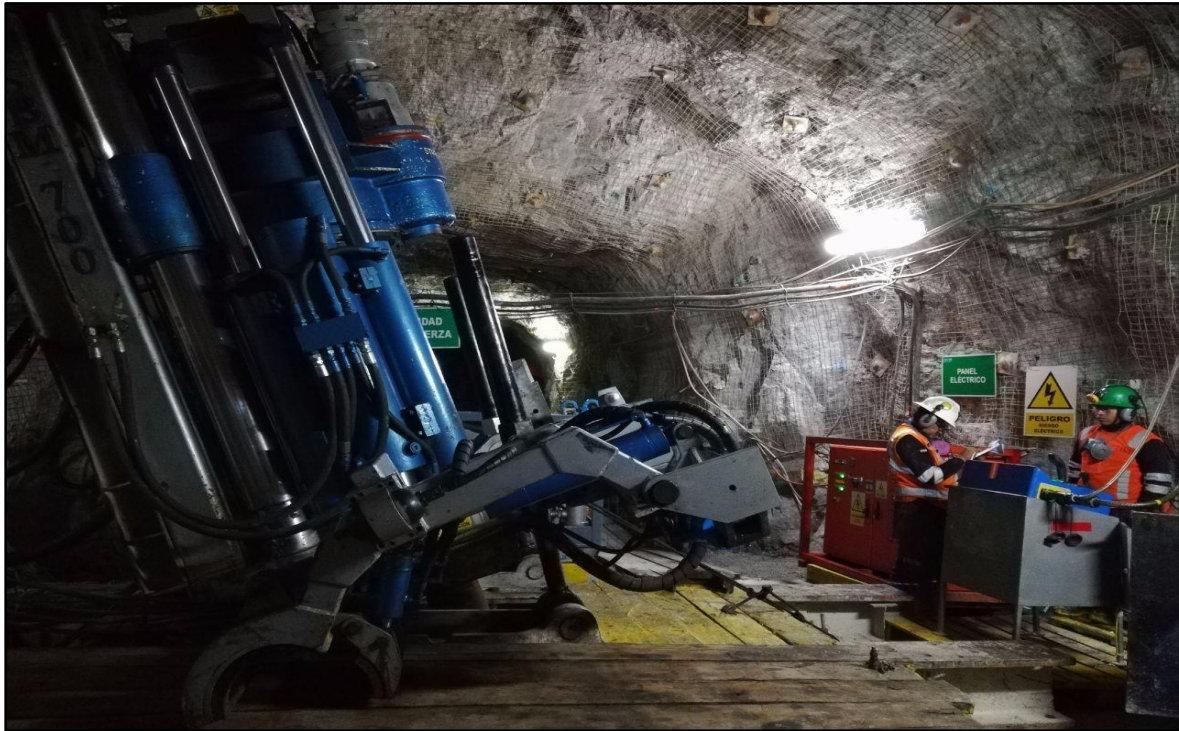
Figura N° 7. Ejecución de taladro piloto con máquina Raise Borer con control geomecánico FUENTE: Elaboración propia.
