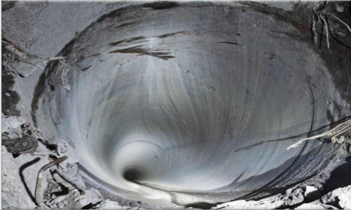
Figura 2.5. Acabado de paredes de una chimenea perforada con máquina Raise Borer FUENTE: Arce L. A. (2015)
