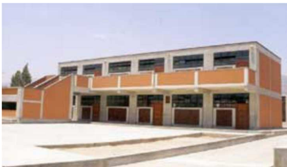
Figura 4.19. Edificio 780 nuevo de 3 aulas por piso en la costa peruana. Fuente: Velázquez 2006
