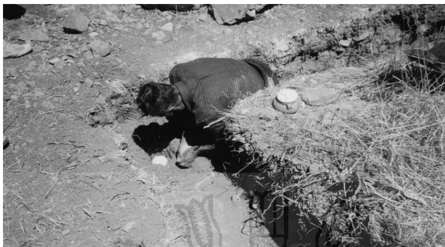
Figura 8. Rituales en el proceso de cimentación.
