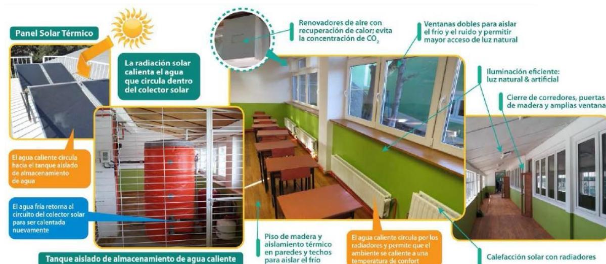
Figura 10: Esquema del sistema de acondicionamiento
