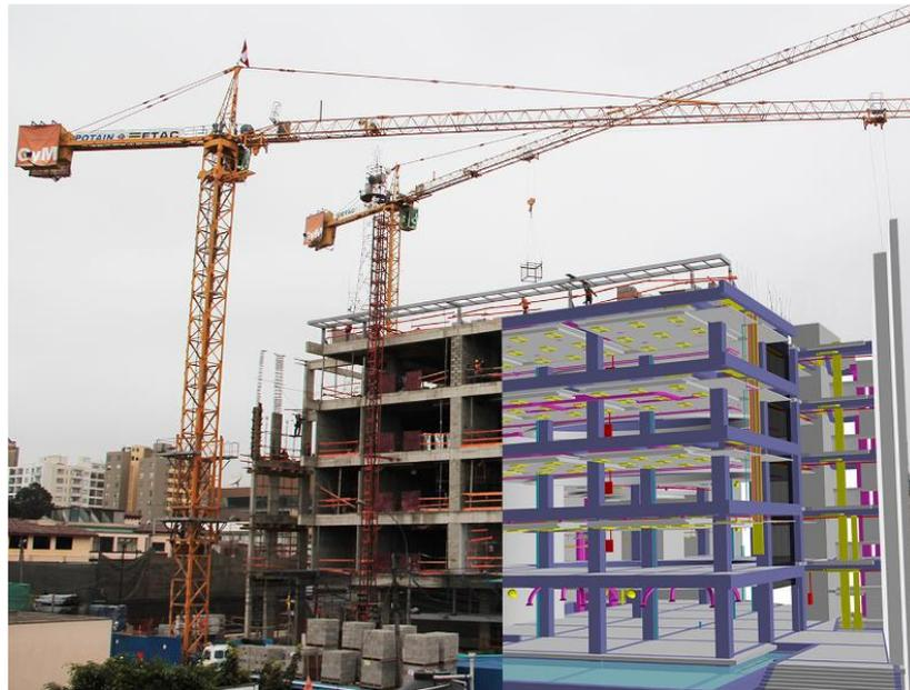
**Figura N° 1:** Representación Virtual BIM-3D (Universidad del Pacífico)
