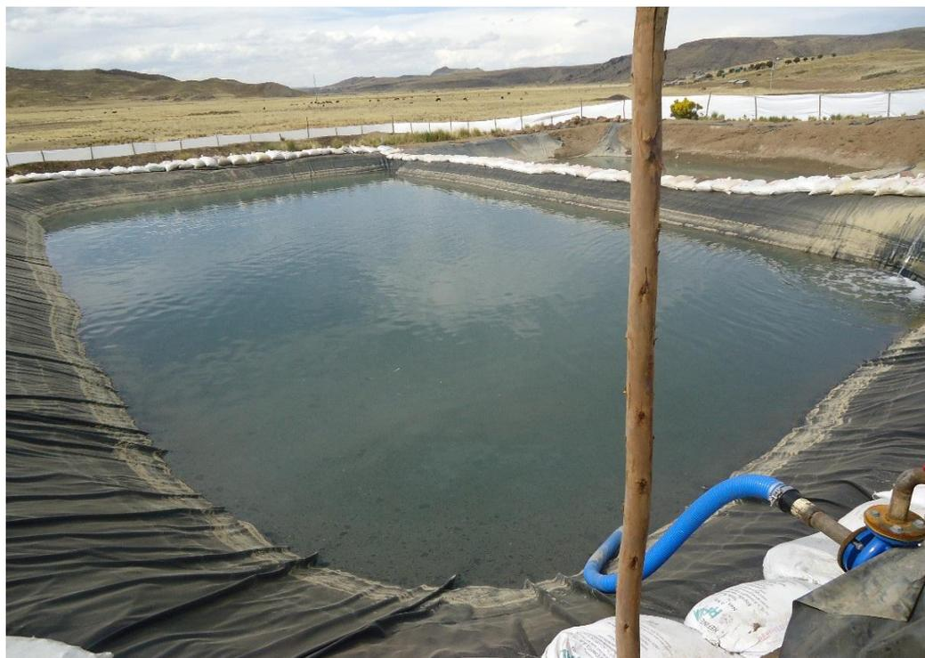
**Figura 11.** MA-4 Poza de Recirculación de Agua Clarificada y Bombeo
