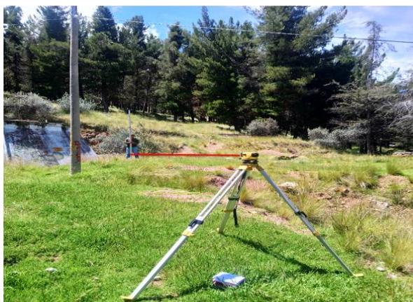
Figura 1 Procedimientos de Nivelación.
