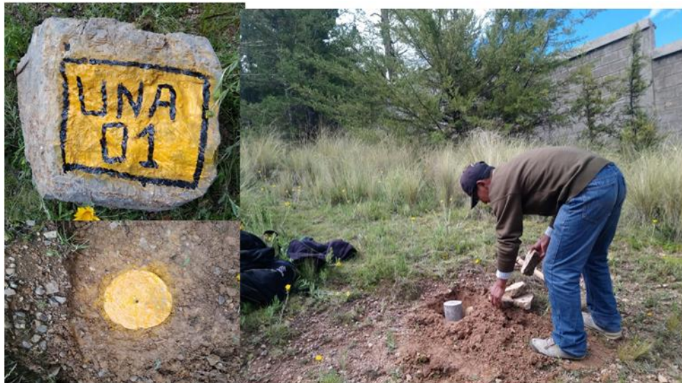
Figura 31 Monumentación de puntos de control para establecer modo RTK.
