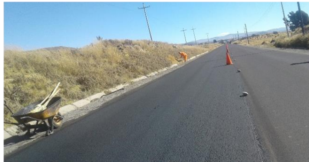
Figura 34. Estado de las vías. Fuente: elaboración propia.
