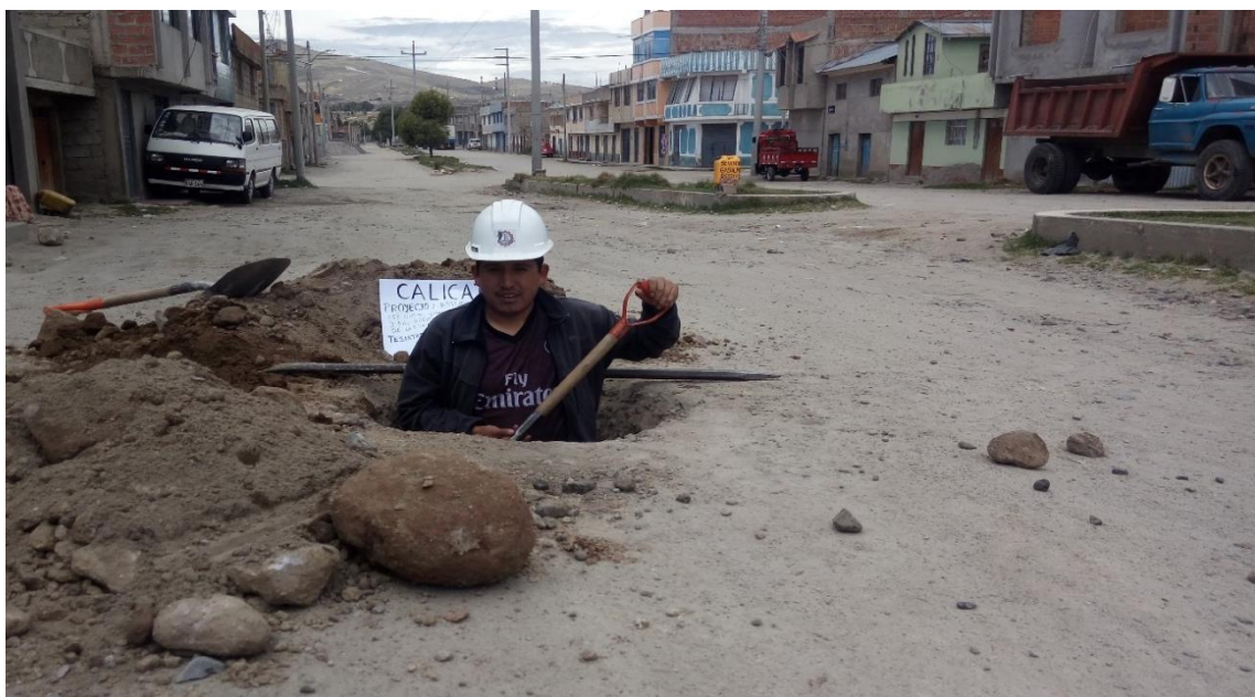
Foto 3: Sondaje y muestreo a través de pozos calicatas a cielo abierto al eje de la vía.
