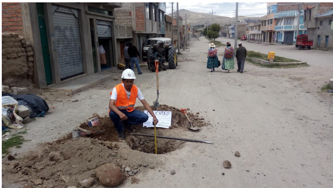
Foto 4: Verificando profundidad mínima de investigación 1.20m siguiendo recomendaciones de acuerdo al manual MTC E101-2000 (Pozos, calicatas, trincheras y zanjas).
