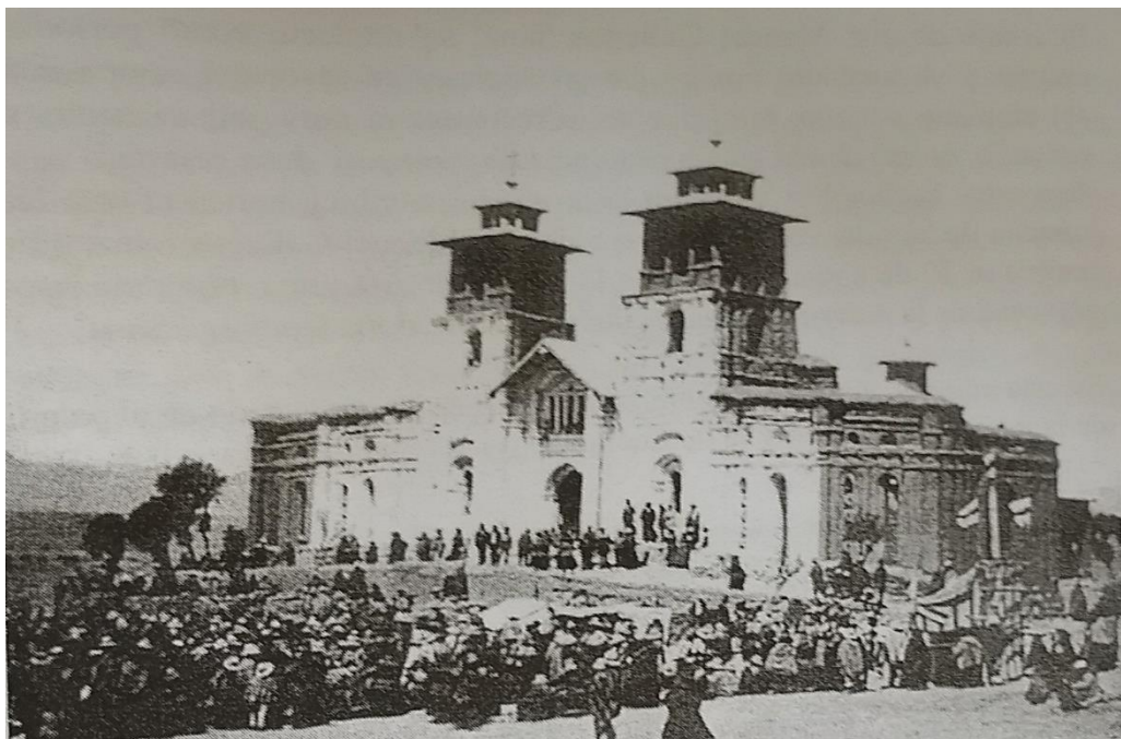
Figura 2 La Iglesia Tintiri una vez Culminado la Construcción
