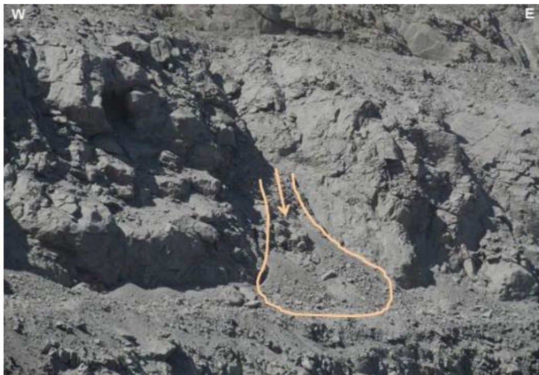
Figura N° 2. 27: Zona de deslizamiento DZ-5, nivel de riesgo bajo. Fuente: Elaboración propia.
