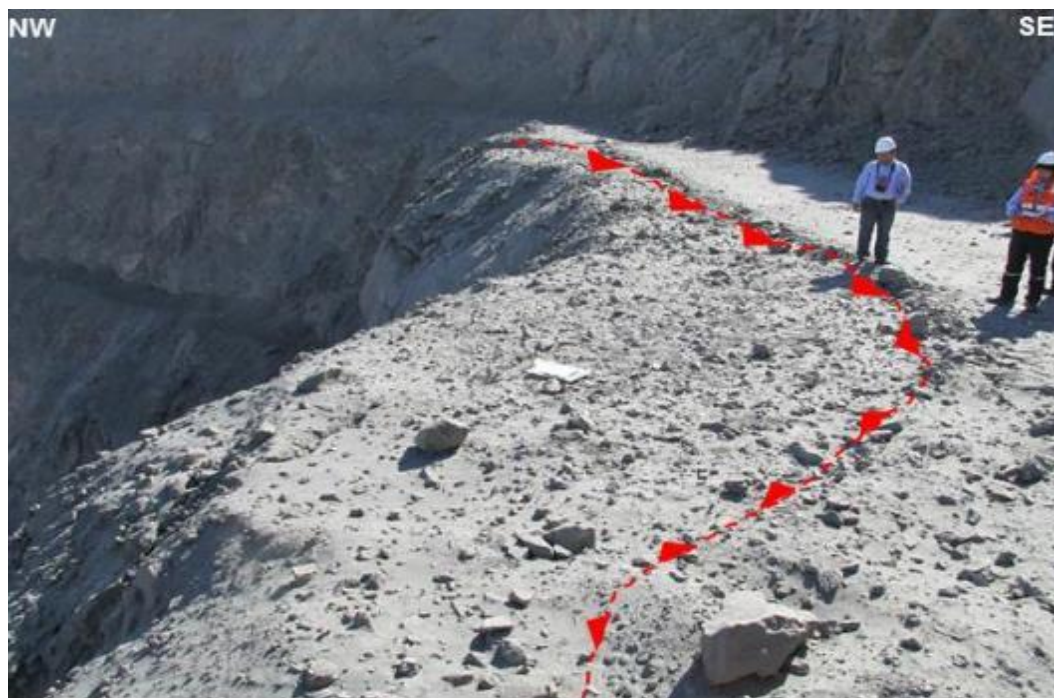
Figura N° 2. 26: Zona de agrietamiento GR-03, nivel de riesgo medio.
