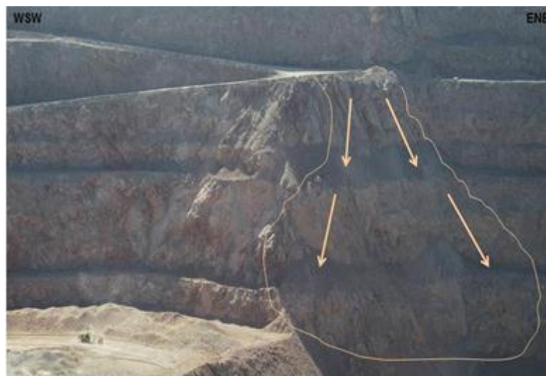
Figura N° 4. 27: Deslizamiento ocurrido en el talud Norte de la Mina 4 Fuente: Elaboración propia.
