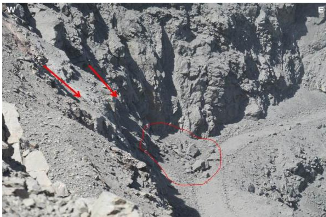
Figura N° 2. 28: Zona de caída de rocas CR-11, nivel de riesgo alto. Fuente: Elaboración propia.
