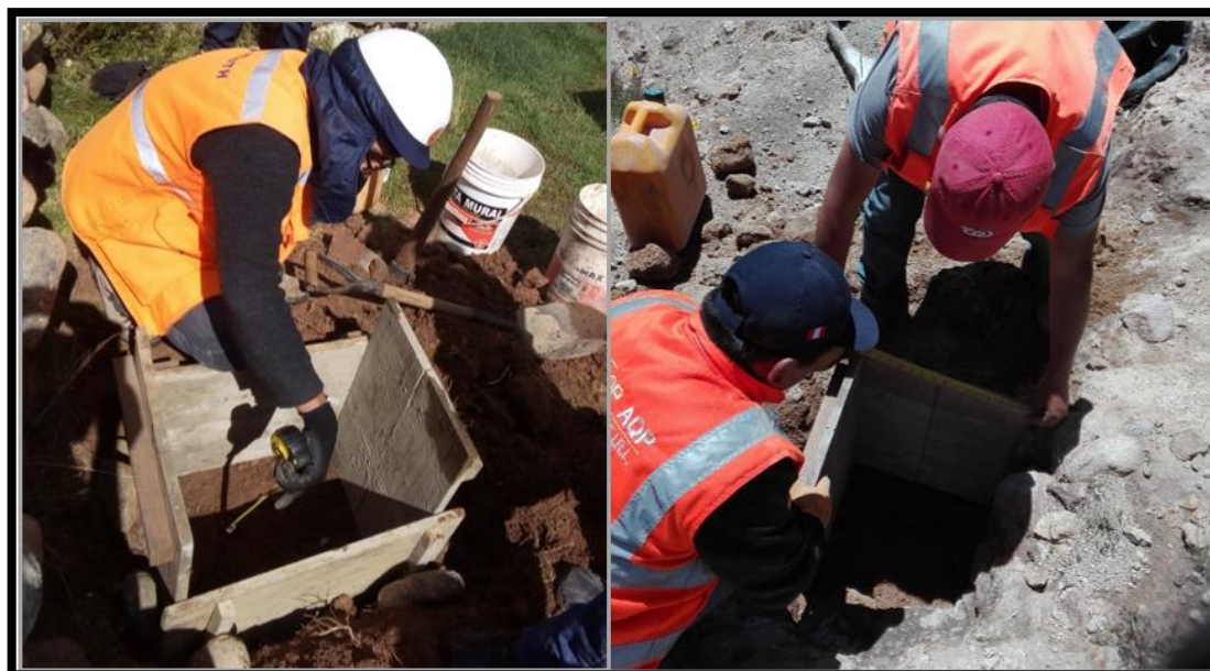
Figura 32: Encofrado para el monumento de los puntos de control geodésico.
