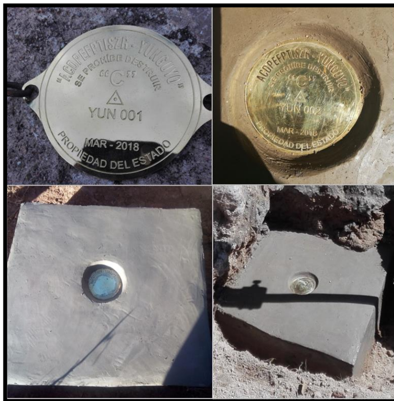
Figura 34: Incrustación de la placa de bronce de 9 cm de diámetro en los dos monumentos con los siguientes códigos “ YUN 001 – YUN 002)
