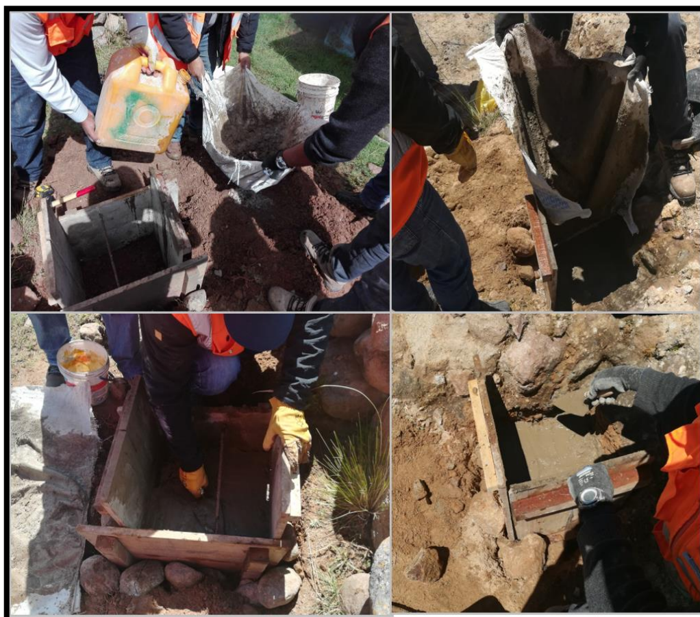
Figura 33: Monumentación del punto de control, usando un concreto de f'c = 210 \text{ Kg/cm}^2 .
