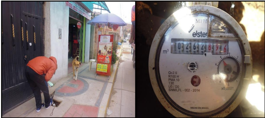
FIGURA 16 LECTURA DEL MICROMEDIDOR EN LA VIVIENDA CODIGO 11. FUENTE: IMAGEN PROPIA
