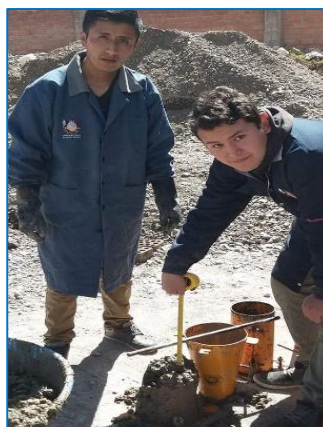
Figura 3.14: Ensayo de asentamiento del concreto.
