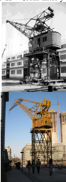
Figura 15 – Grúas antes y después
