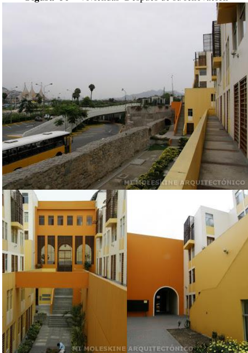
Figura 56 – Viviendas Después de su renovación
