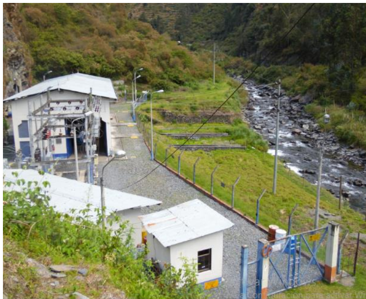
Figura 4.3: Fotografía central hidroeléctrica de Chijisia – Sandia
