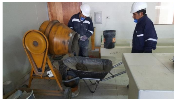
Mezclado del concreto Fecha: 12 /09/2017
