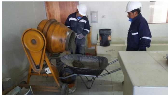
Figura 3.29: Mezclado del concreto Fecha: 12 /09/2017
