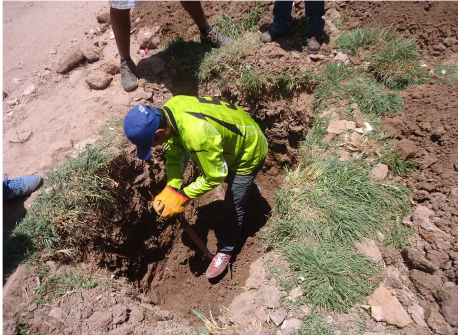
Fotografía N° 03: Excavación de la calicata, N°03
