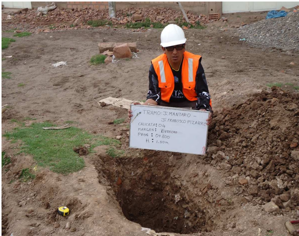
Fotografía N° 06: Excavación de la calicata
