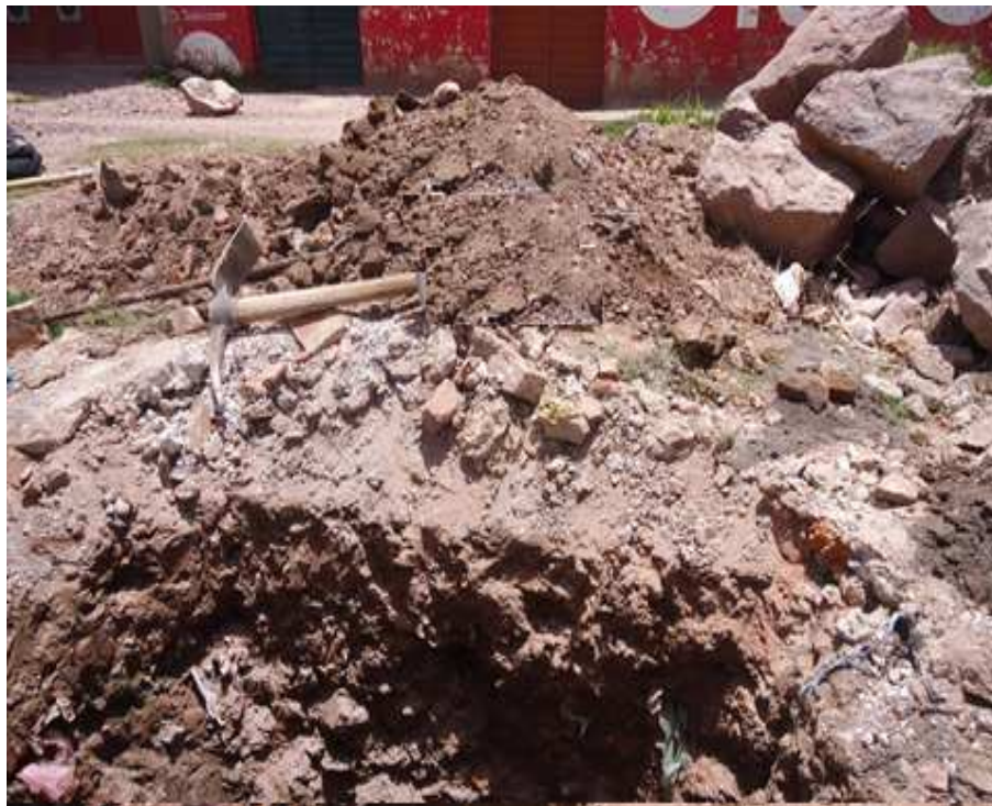
Fotografía N° 04: Excavación de la calicata, N°04
