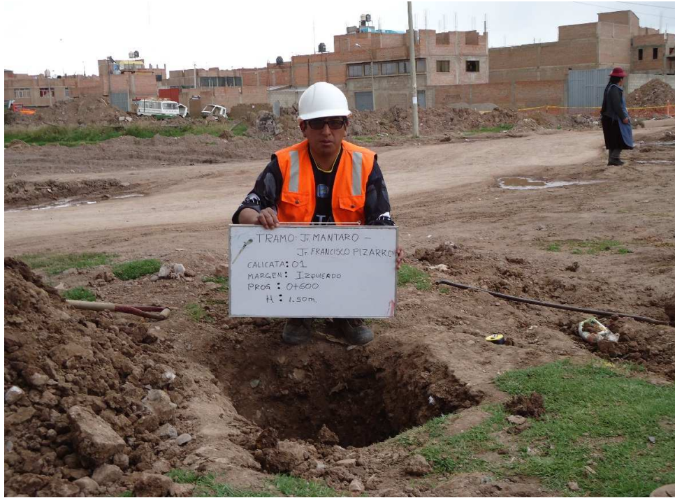
Fotografía N° 05: Excavación de la calicata
