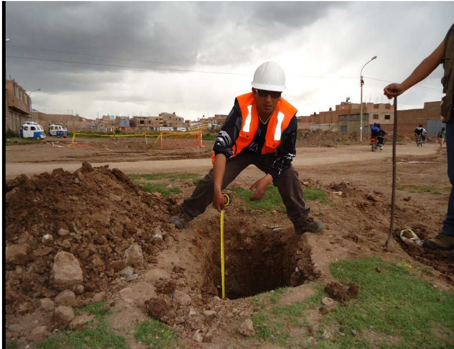
Fotografía N° 02: Excavación de la calicata , N°02
