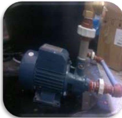
Figura 29 Bomba Centrífuga
