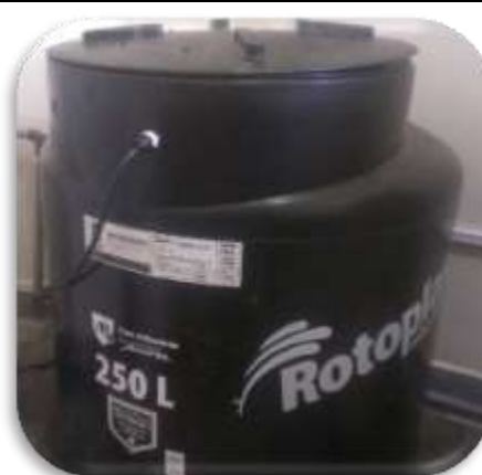
Fotografía 12: tanque de almacenamiento para el agua blanda
