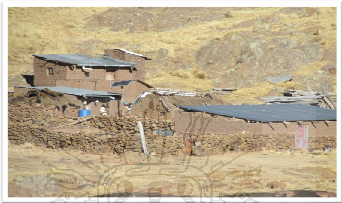
Figura 6. Vivienda aledaña a la mina
