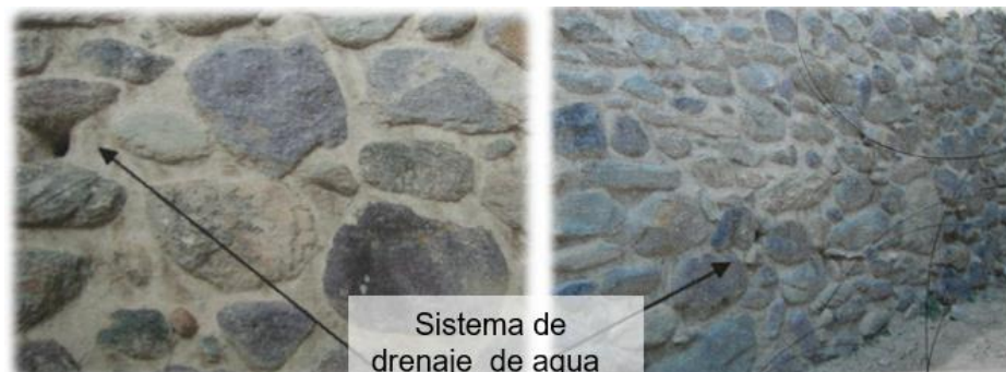
Figura 94: Sistema de drenaje de agua de anden tipo 2 presente en el sector de Qéllorakay. Ollantaytambo. Fuente: propia.
