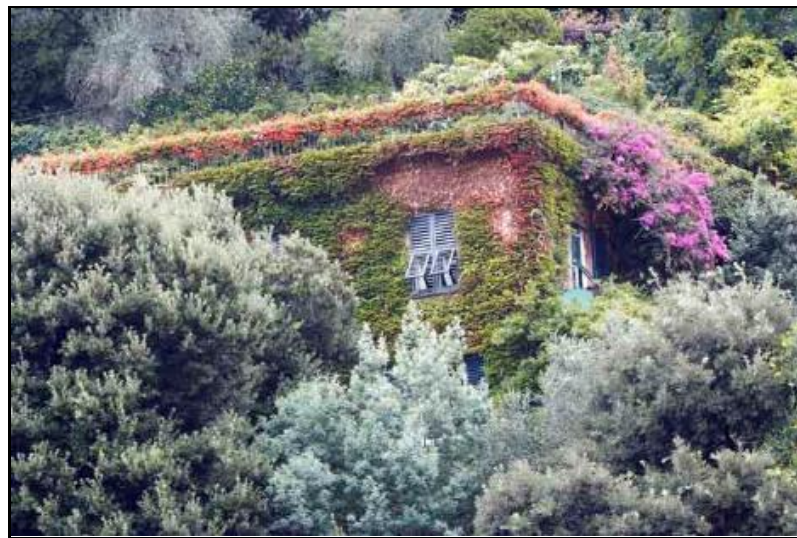
Gráfico 17.- Fachada y cubierta vegetal.
