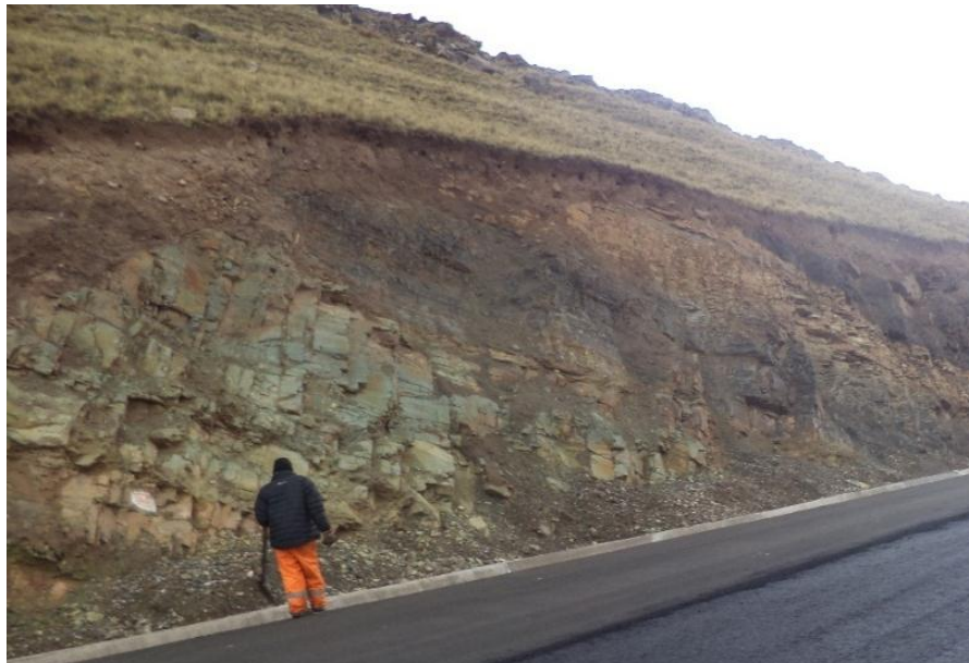
FIGURA N° 28: En la fotografía se aprecia tres familias de discontinuidades en el macizo rocoso de arenisca cuarzosa en La Prog. 17+010 al 17+080.
