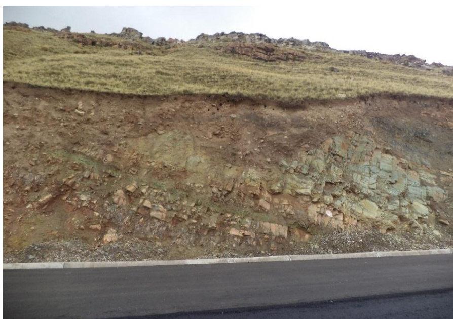
FIGURA N° 27: En esta imagen se aprecia un afloramiento del macizo rocoso de arenisca cuarzosa en la progresiva Km 17+010 - Km 17+080.
