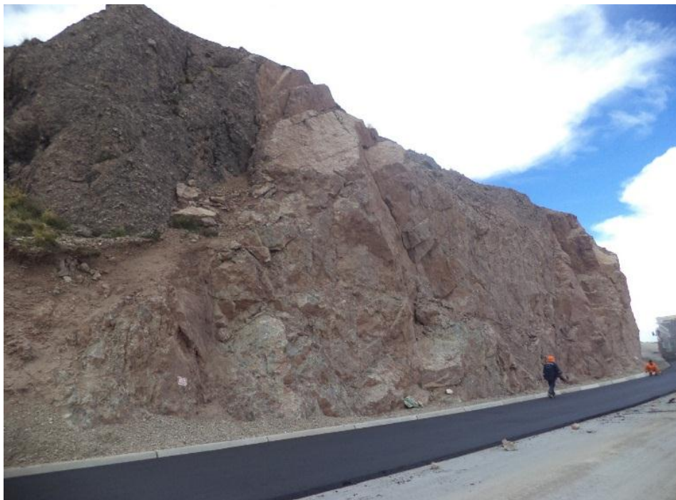
FIGURA N° 48: Afloramiento del macizo rocoso se aprecia una roca sedimentaria de arenisca cuarzosa, en la Progresiva Km 26+480- Km 26+540.
