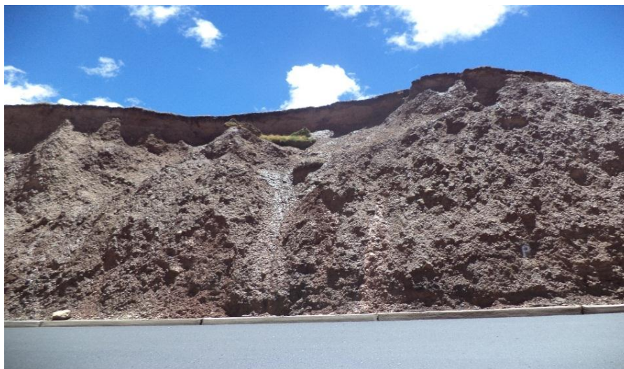
FIGURA N° 24: En la imagen se aprecia el Talud inestable de material coloidal de la Progresiva Km 16+100- Km 16+200.
