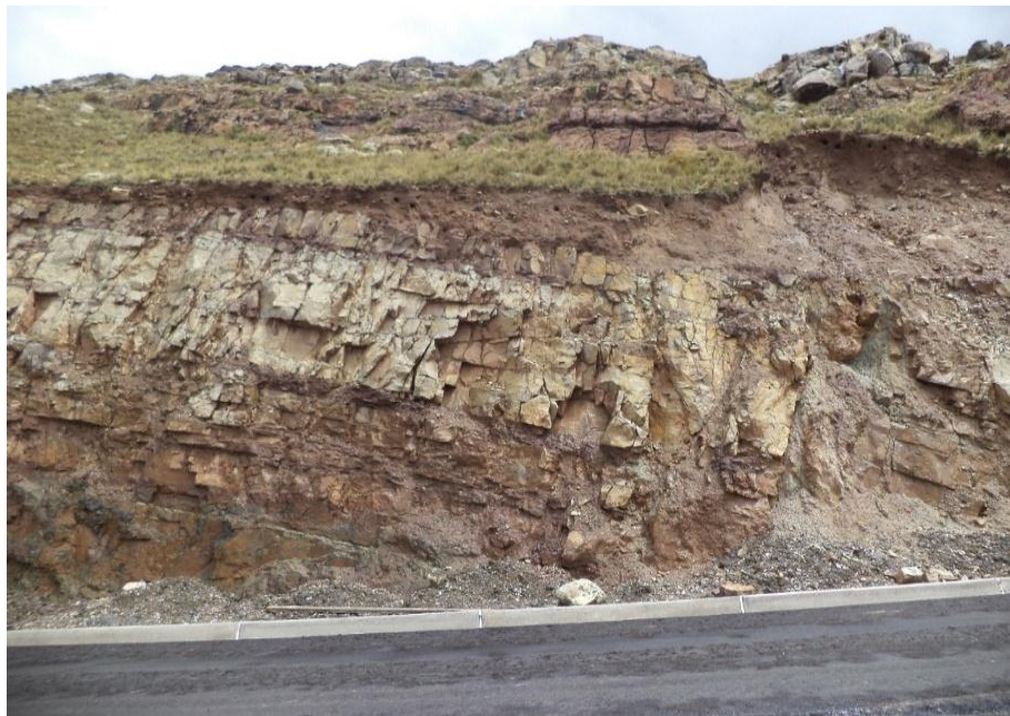
FIGURA N° 38: Afloramiento del macizo rocoso de arenisca en la Progresiva Km 20+080- Km 20+160.
